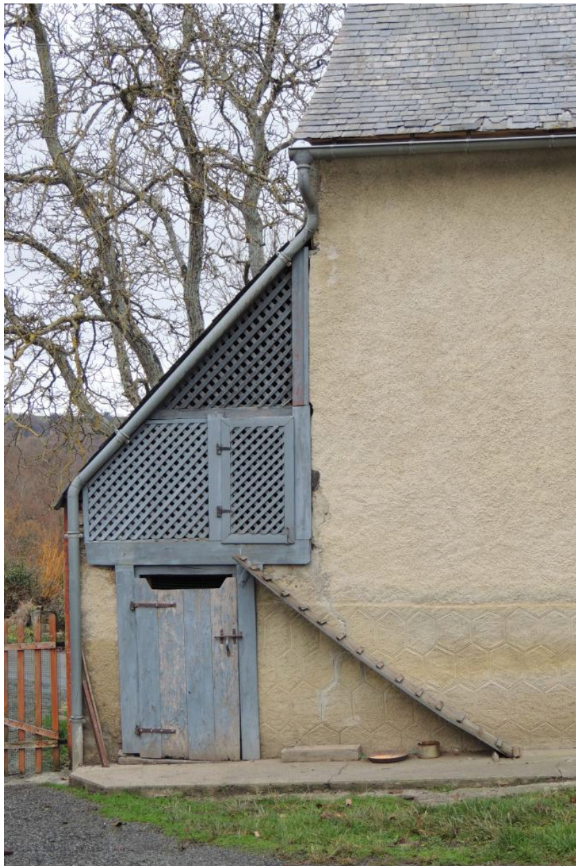
Détail du toit à porc surmonté d'un poulailler accolé au sud-ouest de l'habitation.
