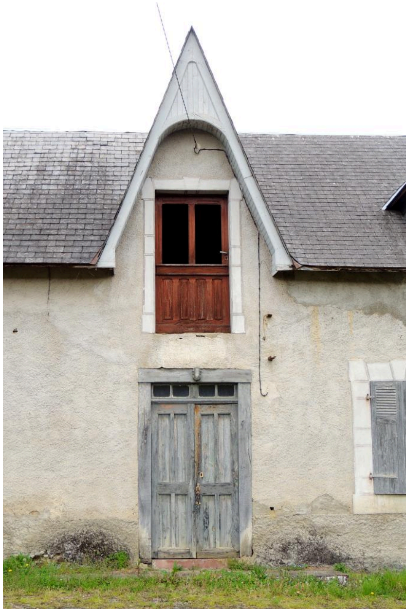
Détail de la partie centrale de l'élévation sud.
