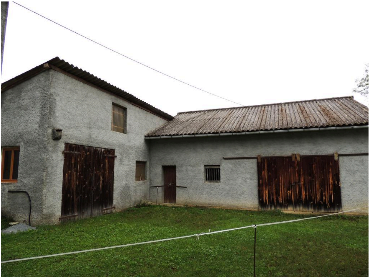
Vue générale des dépendances depuis le sud-est (étable, remises).
