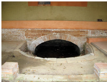
Entrée du foyer. Phot. Jérôme Bonhôte IVR76_20213100138NUCA
