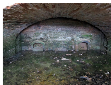
Vue de l'intérieur du four. Phot. Jérôme Bonhôte IVR76_20213100132NUCA
