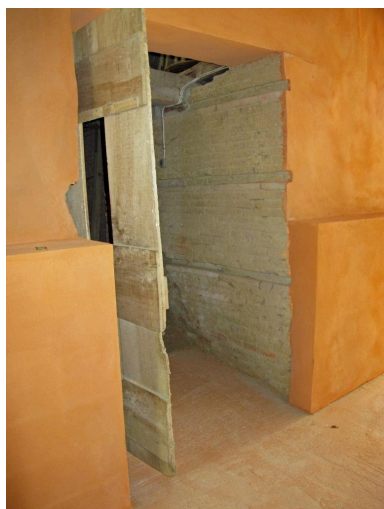
Entrée de la chambre de cuisson. Phot. Jérôme Bonhôte IVR76_20213100148NUCA
