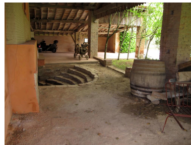
Vue d'ensemble de l'appentis devant le four. Phot. Jérôme Bonhôte IVR76_20213100146NUCA
