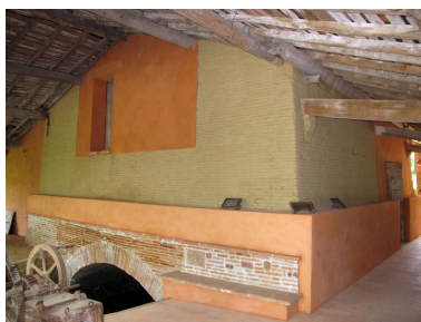
Vue générale du four après transformation. Phot. Jérôme Bonhôte IVR76_20213100147NUCA
