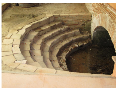
Entrée du foyer. Phot. Jérôme Bonhôte IVR76_20213100140NUCA
