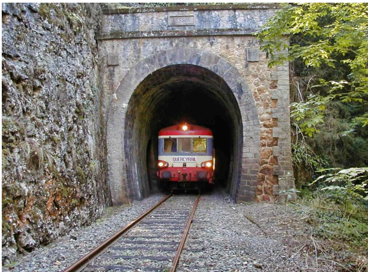
Le train X4519 traversant le tunnel de Bessac en 2002.
