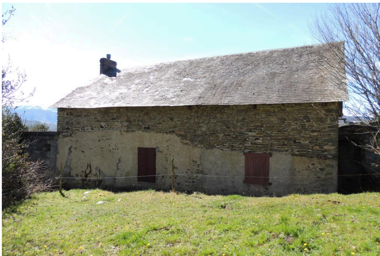
Vue de l'élévation nord.
