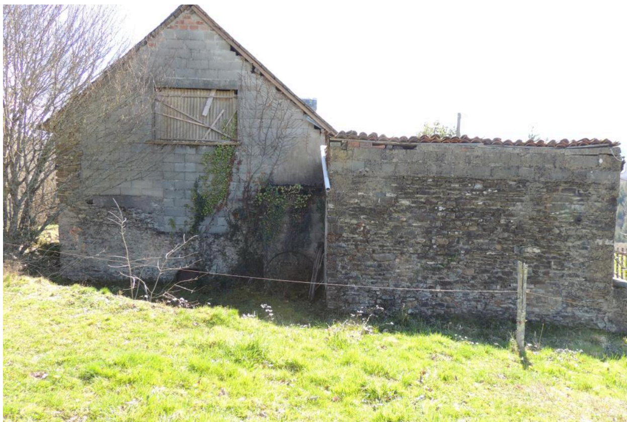
Vue de l'élévation ouest.
