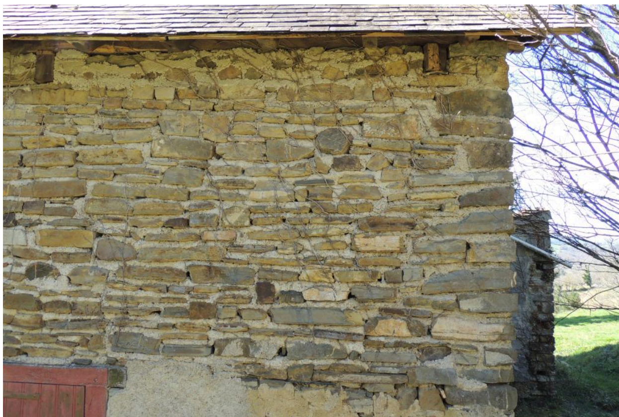
Détail de l'appareil de l'élévation nord.
