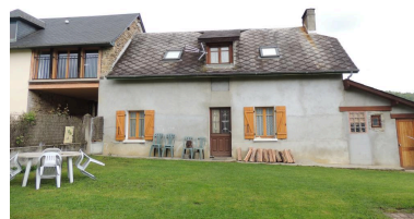
Vue de l'élévation principale depuis le sud. Phot. Marion Fourcayran IVD65_20136500272NUCA
