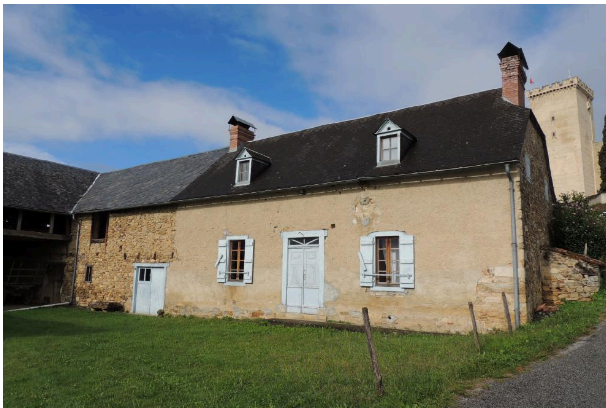
Vue de la façade du logis.
