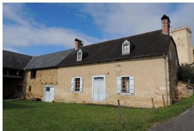
Vue de la façade du logis. Phot. Marion Fourcayran IVD65_20146500625NUCA
