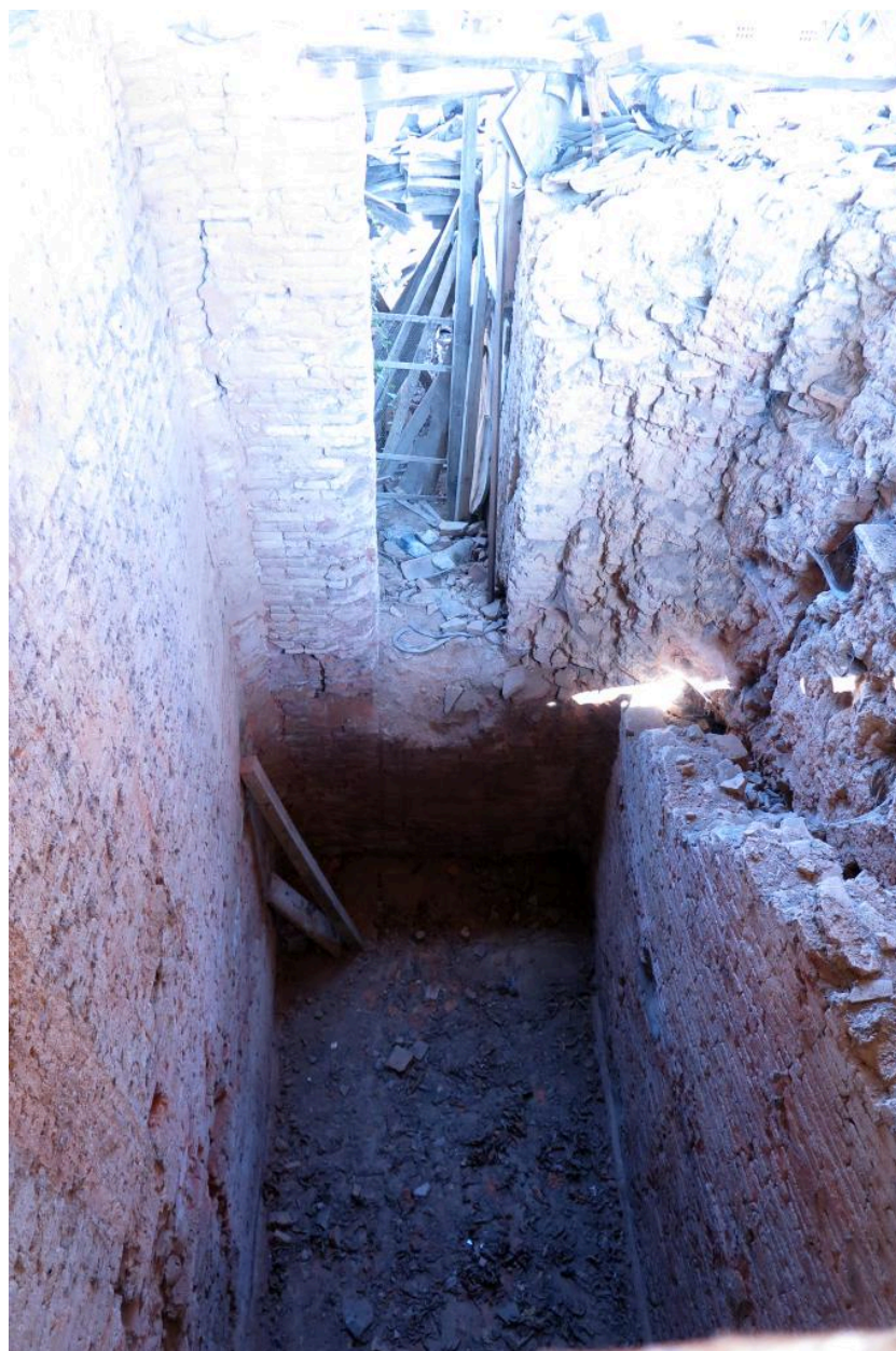
Vue plongeante sur le laboratoire et la porte d'enfournement.
