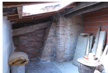
Partie haute du contrefort situé à droite de l'alandier. Phot. Jérôme Bonhôte IVR76_20203100013NUCA
