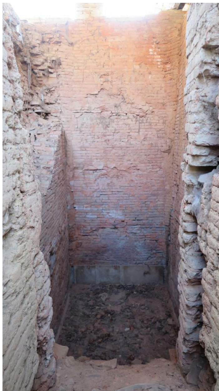
Elévation du laboratoire depuis la porte d'enfournement.
