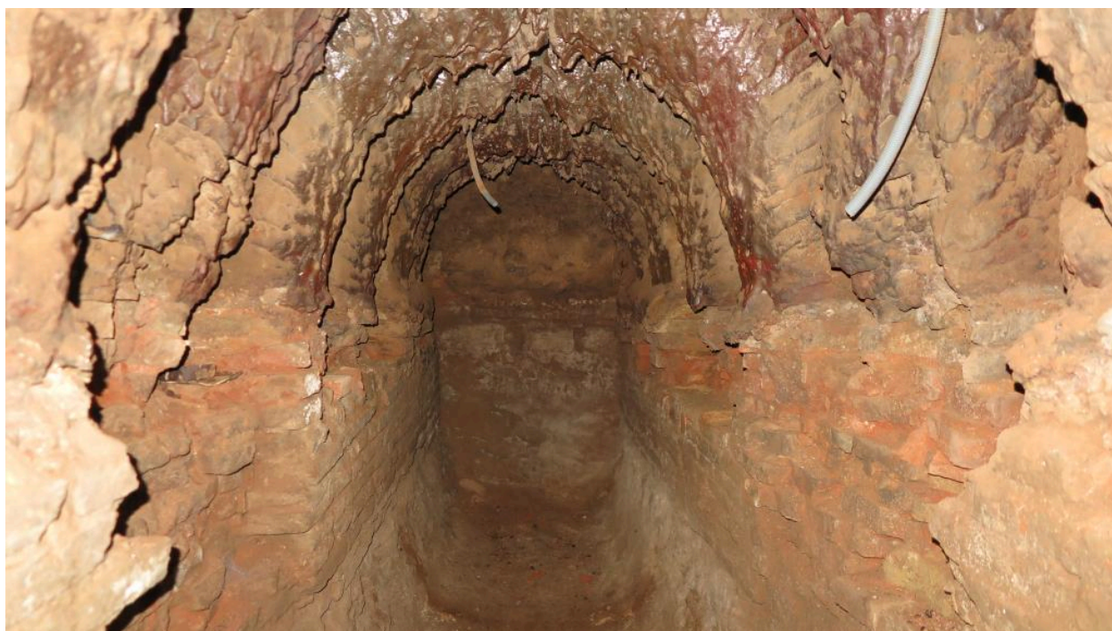
Alandier vue partielle.
