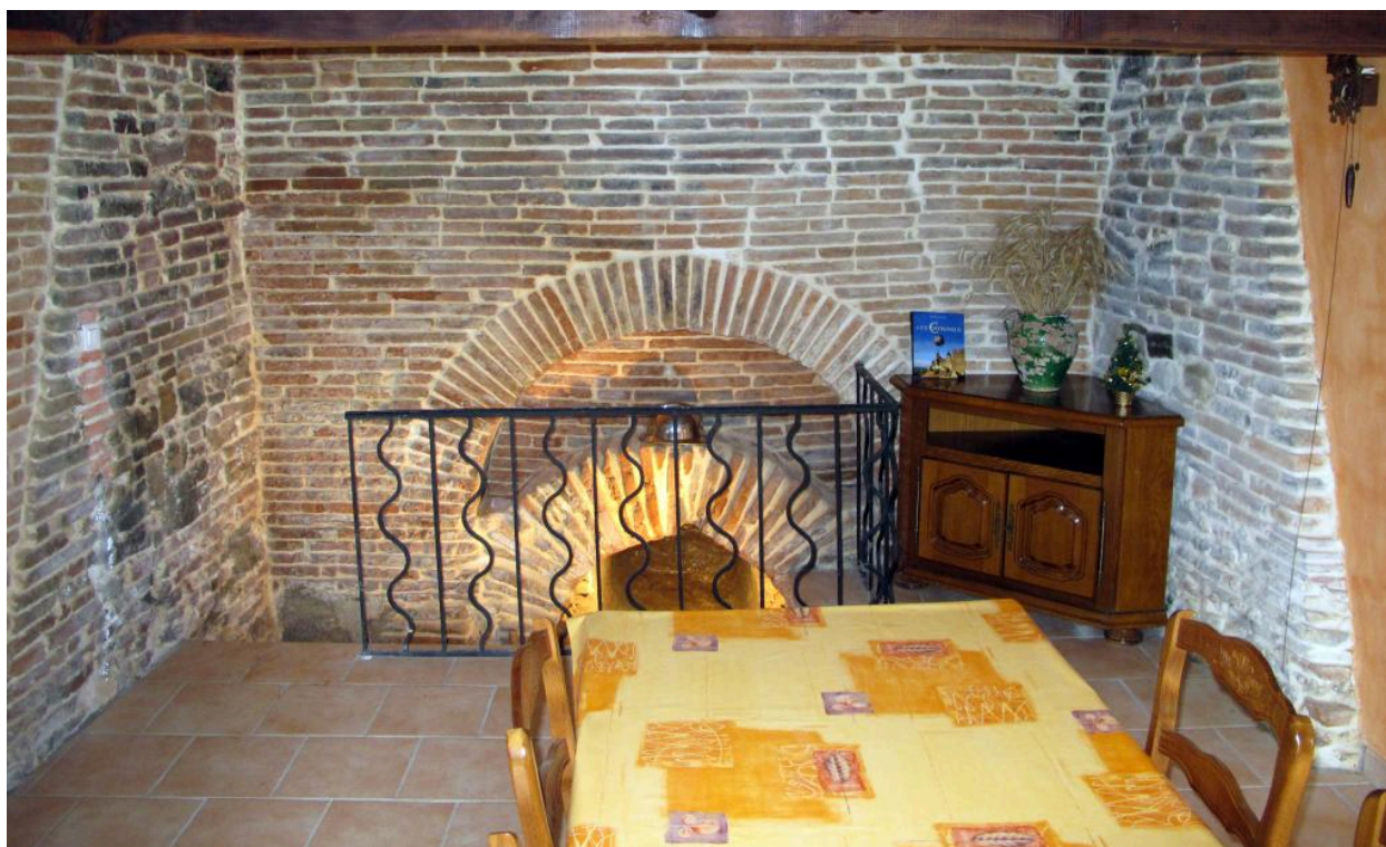
Contreforts soutenant l'alandier.
