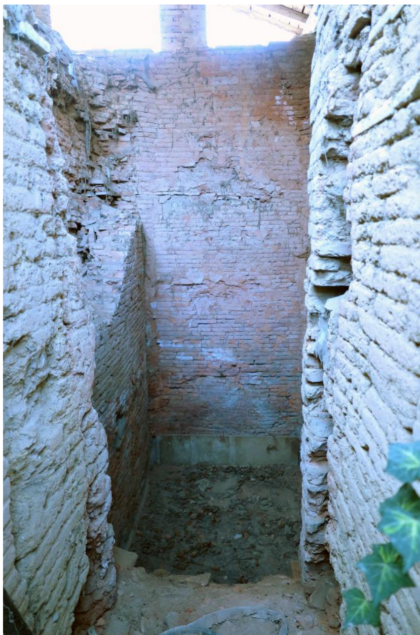
Elévation du laboratoire depuis la porte d'enfournement des produits.
