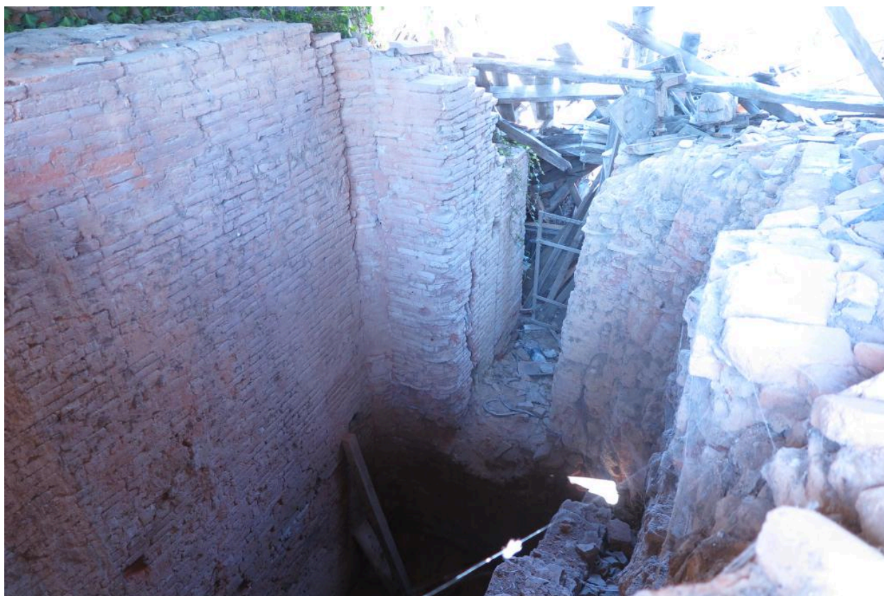
Vue plongeante sur le laboratoire vers la porte d'enfournement.
