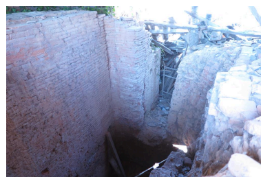
Vue plongeante sur le laboratoire vers la porte d'enfournement. Phot. Jérôme Bonhôte IVR76_20203100010NUCA
