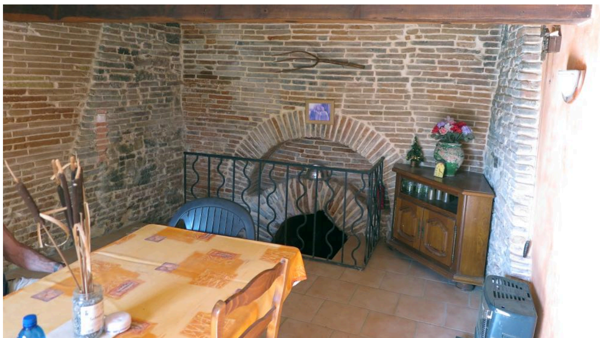
Contreforts soutenant l'alandier.
