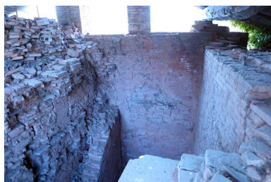
Vue de la partie haute du Laboratoire depuis la porte d'enfournement. Phot. Jérôme Bonhôte IVR76_20203100007NUCA
