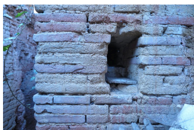
Niche située sur le côté droit de la porte d'enfournement. Phot. Jérôme Bonhôte IVR76_20203100008NUCA
