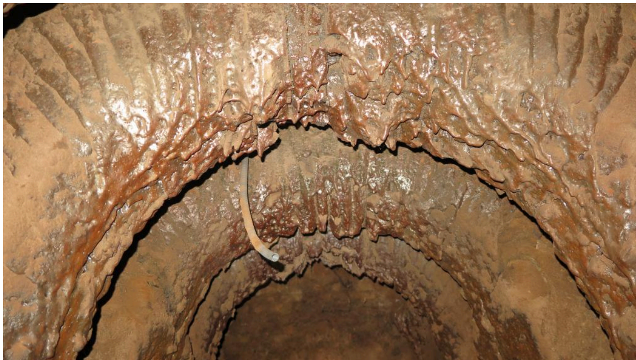
Détail de la voûte vitrifiée de l'alandier.
