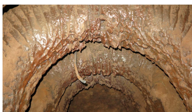
Détail de la voûte vitrifiée de l'alandier. Phot. Jérôme Bonhôte IVR76_20203100017NUCA
