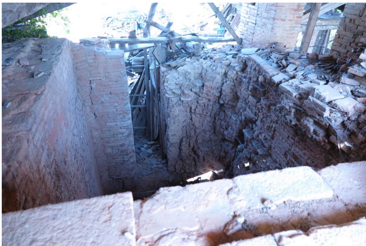
Vue d'ensemble du laboratoire depuis le haut du four vers la porte d'enfournement des produits.
