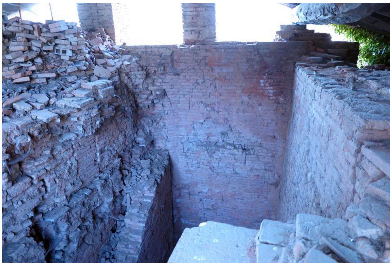
Vue de la partie haute du Laboratoire depuis la porte d'enfournement.
