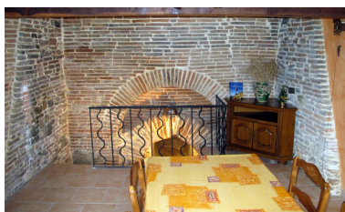
Contreforts soutenant l'alandier. Phot. Jérôme Bonhôte IVR76_20203100028NUCA
