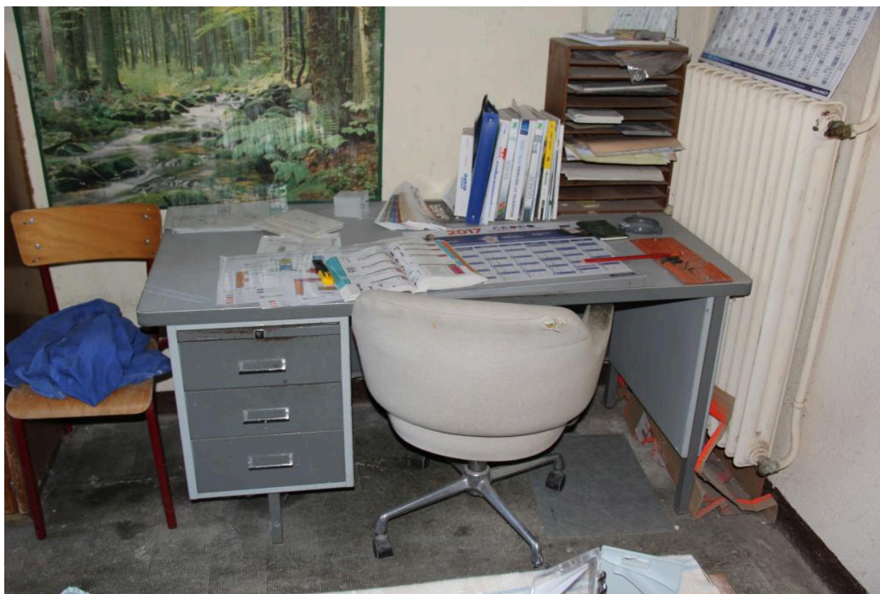
Vue d'un ancien bureau dans l'atelier situé en étage de soubassement du bâtiment A.
