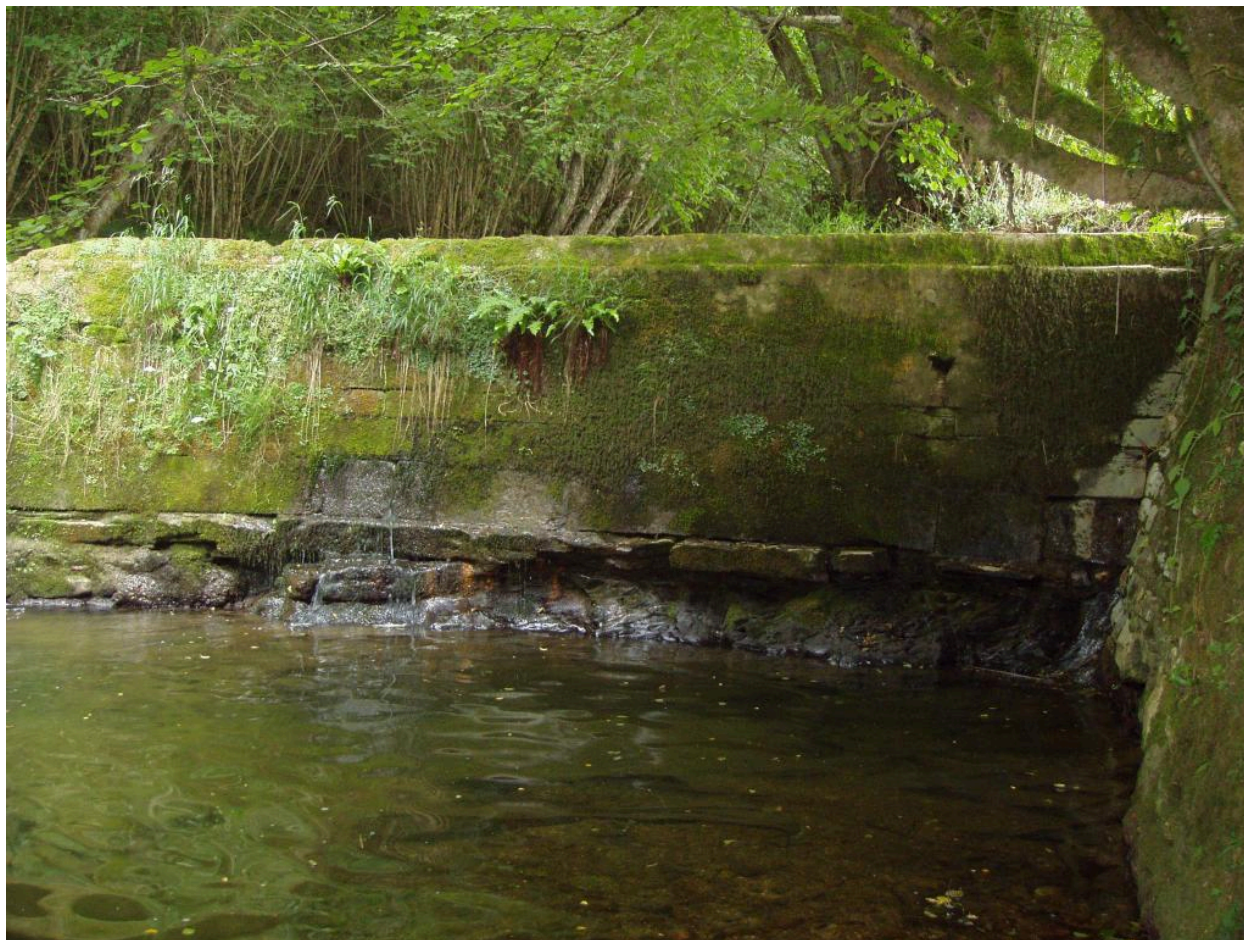
Détail de la digue sur le bief de dérivation.
