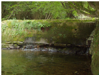
Détail de la digue sur le bief de dérivation. Phot. Camille Ducasse IVD65_20116500016NUCA
