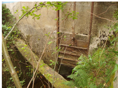
Détail de la vanne sur le canal d'amenée. Phot. Camille Ducasse IVD65_20116500018NUCA
