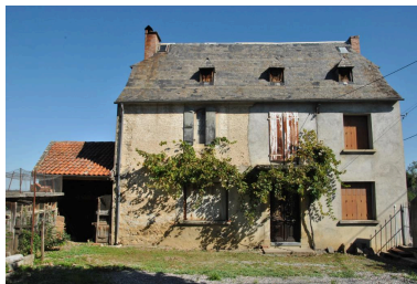
Vue de l'élévation principale depuis le sud. Phot. Marion Fourcayran IVD65_20146500395NUCA
