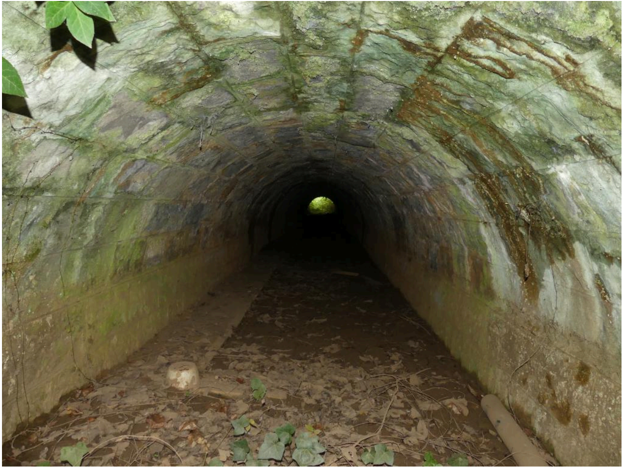
Aqueduc, près de la gare de Saint-Martin-Labouval.
