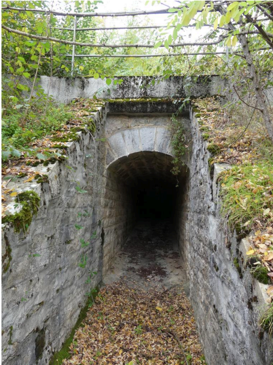
Aqueduc (PK 32k650m).
