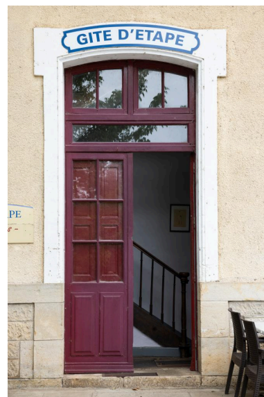
Porte d'accès directe à l'escalier intérieur. Phot. Amélie Boyer IVR76_20244650213NUCA
