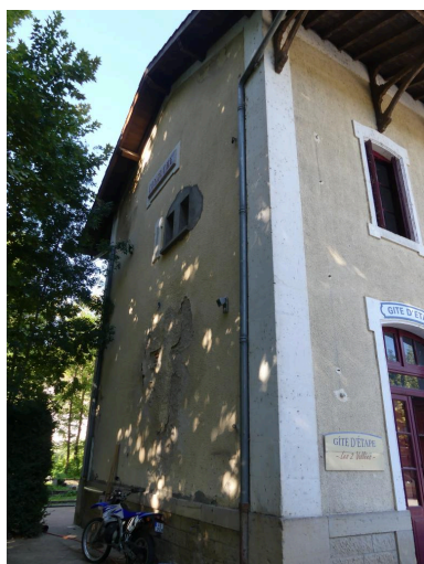
Bâtiment des voyageurs : vue du mur-pignon sud-est. Phot. Guillaume Bernard, Phot. Fabien Cadot IVD46_20204602071NUCA
