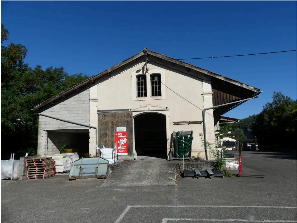
Halles à marchandises : vue depuis le sud-est.
