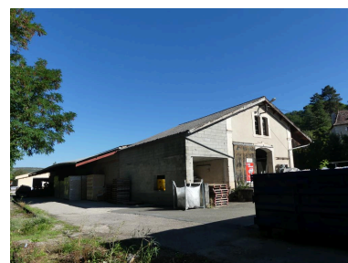
Halles à marchandises : vue depuis le sud. Phot. Guillaume Bernard, Phot. Fabien Cadot IVD46_20204602068NUCA
