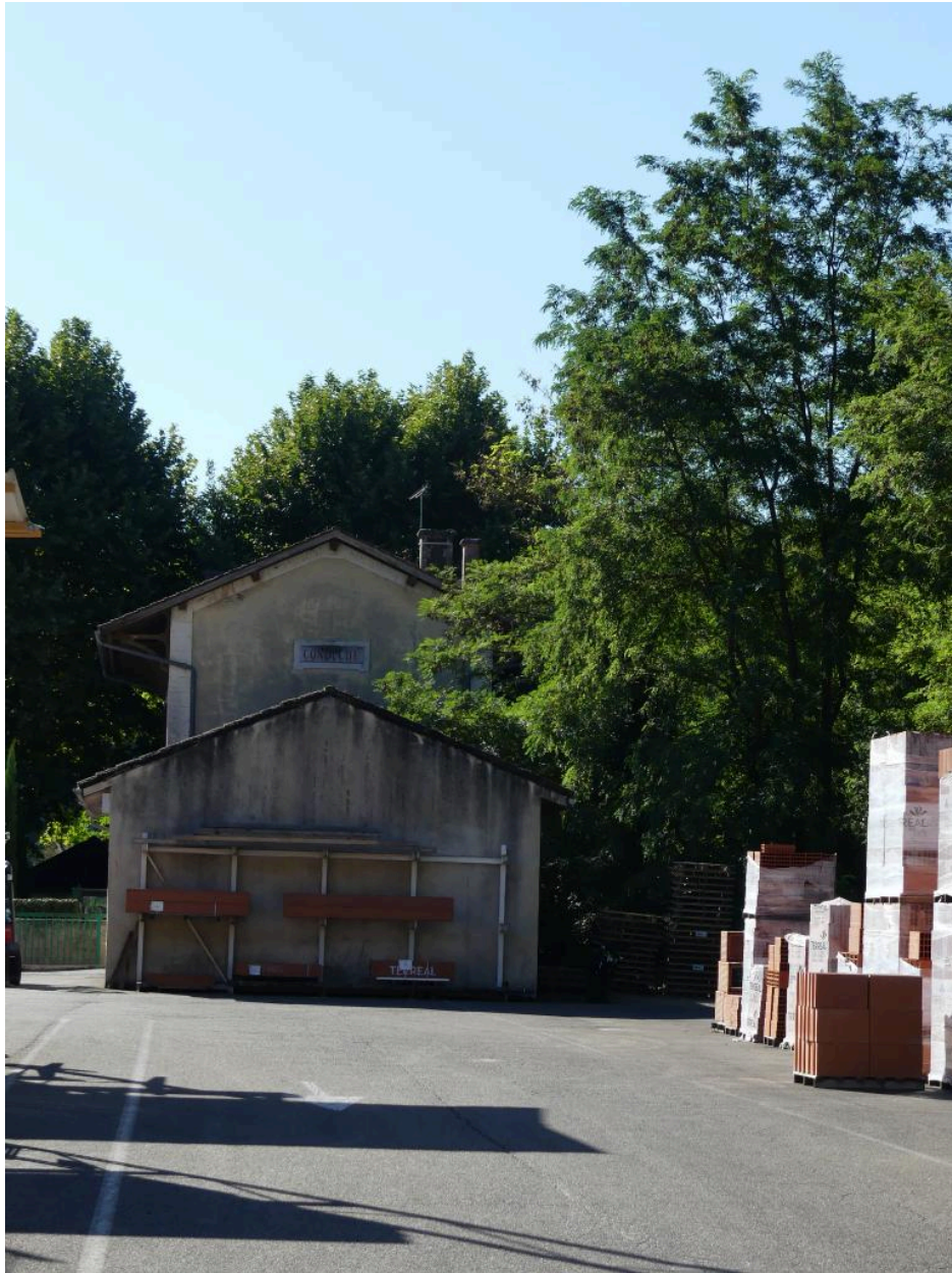
Bâtiment des voyageurs : vue depuis le nord-ouest.
