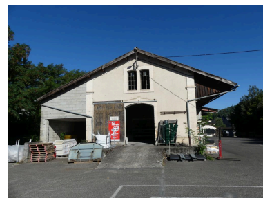
Halles à marchandises : vue depuis le sud-est.
