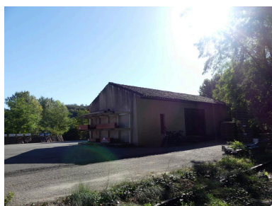
Entrepôt entre le bâtiment des voyageurs et les halles à marchandises. Phot. Guillaume Bernard, Phot. Fabien Cadot IVD46_20204602077NUCA
