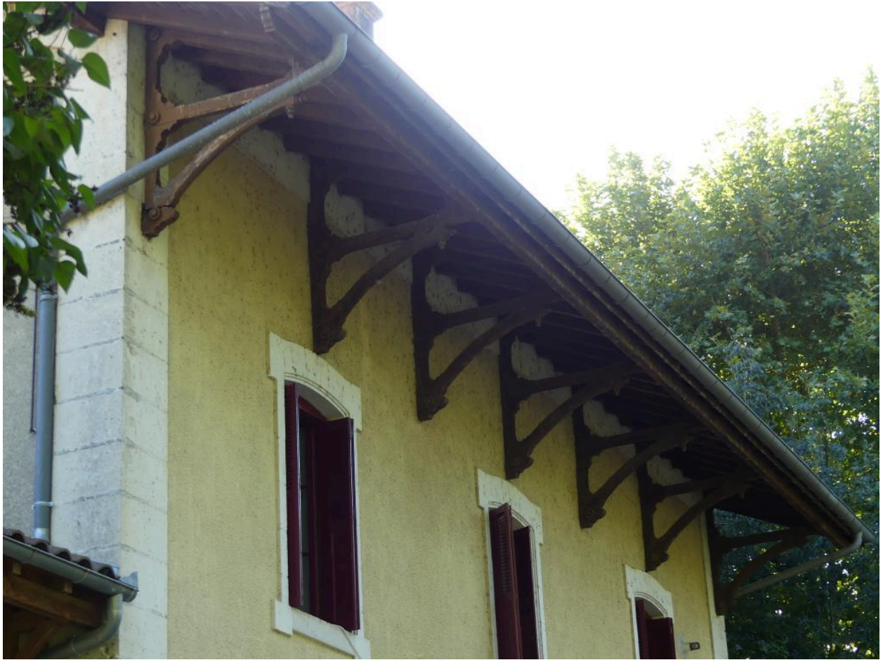
Bâtiment des voyageurs, élévation sud-ouest : débord de toiture.
