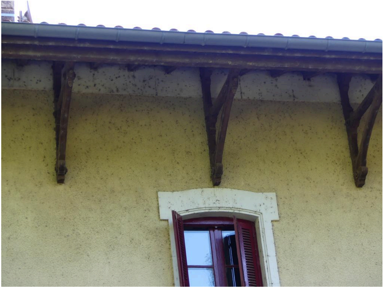
Bâtiment des voyageurs, élévation sud-ouest : détail aisseliers.
