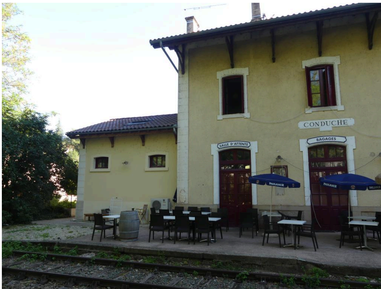
Bâtiment des voyageurs, élévation sud-ouest : corps en rez-de-chaussée accolé au nord-ouest.
