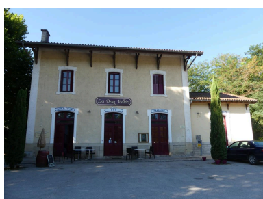
Bâtiment des voyageurs : élévation nord-est. Phot. Guillaume Bernard, Phot. Fabien Cadot IVD46_20204602074NUCA
