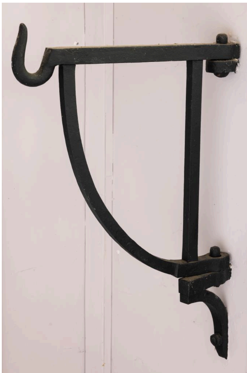
Vue intérieure : crochet pivotant pour la descente à la cave.
