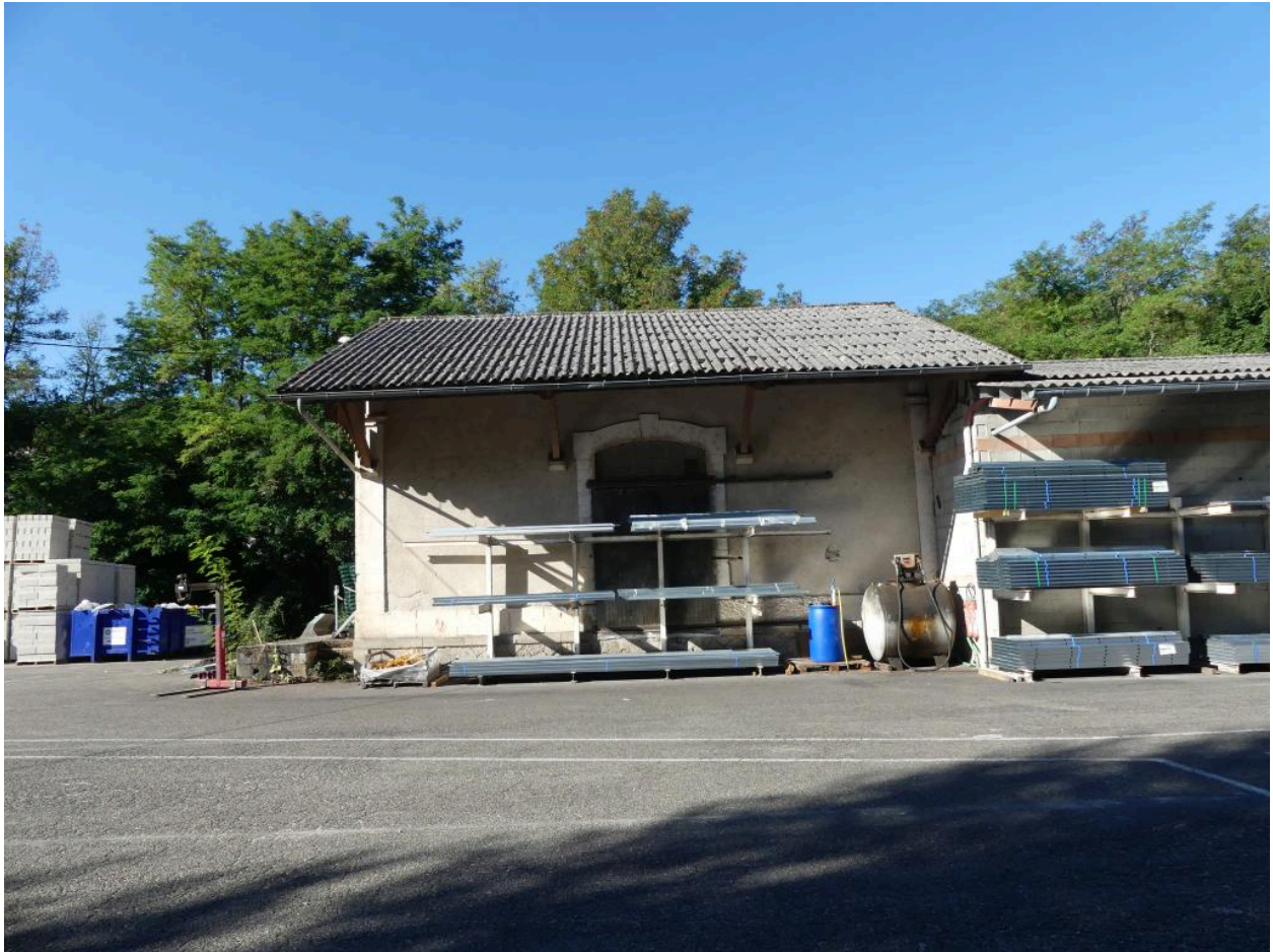
Halles à marchandises : élévation nord-est.
