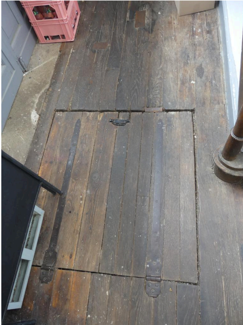
Trappe ménagée dans le plancher du rez-de-chaussée, devant l'escalier.
