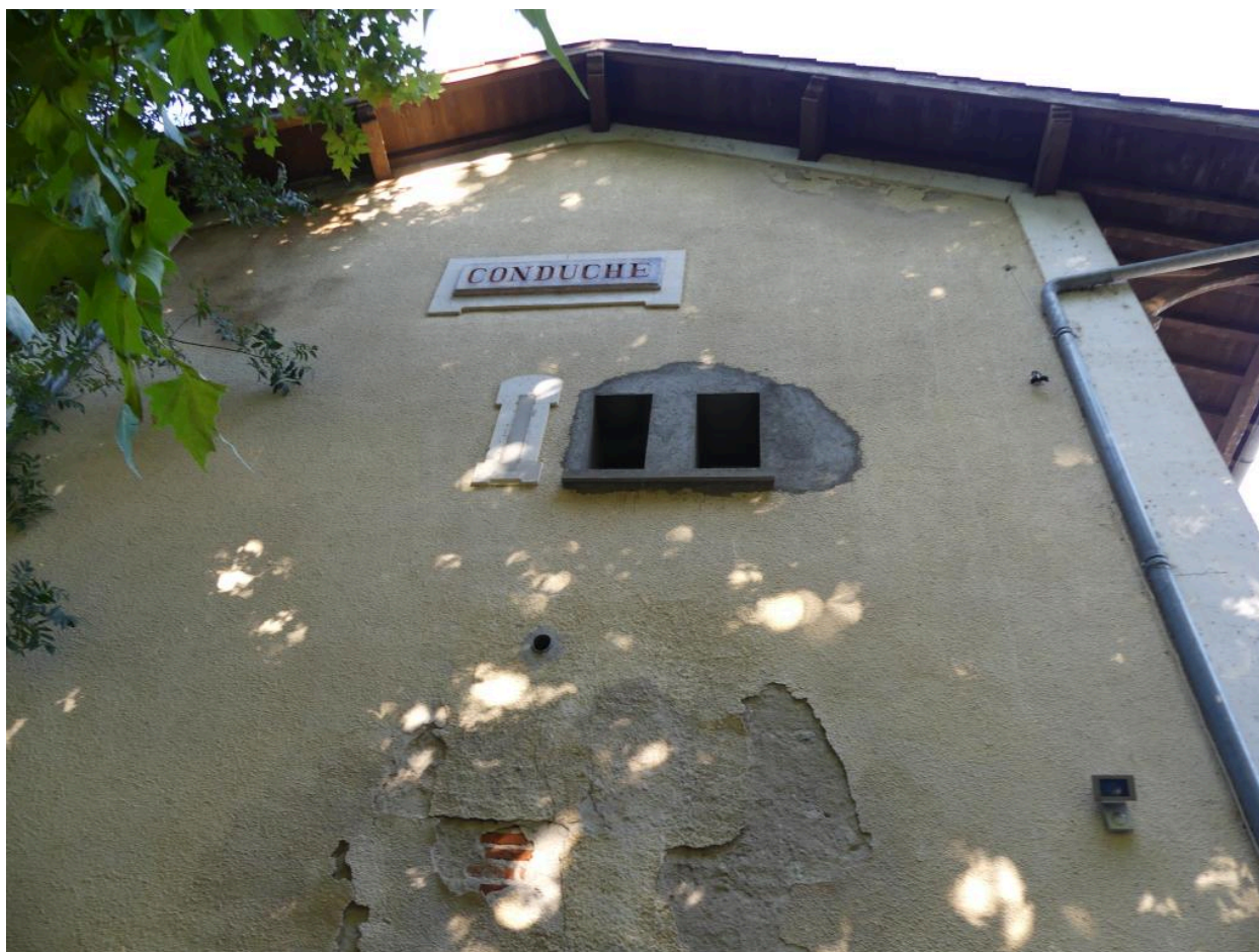
Bâtiment des voyageurs : vue du mur-pignon sud-est.
