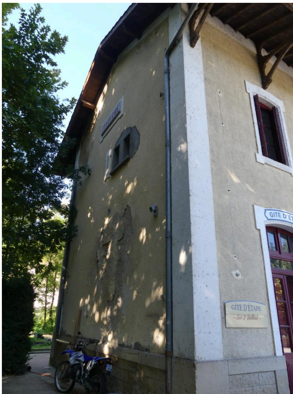
Bâtiment des voyageurs : vue du mur-pignon sud-est.
