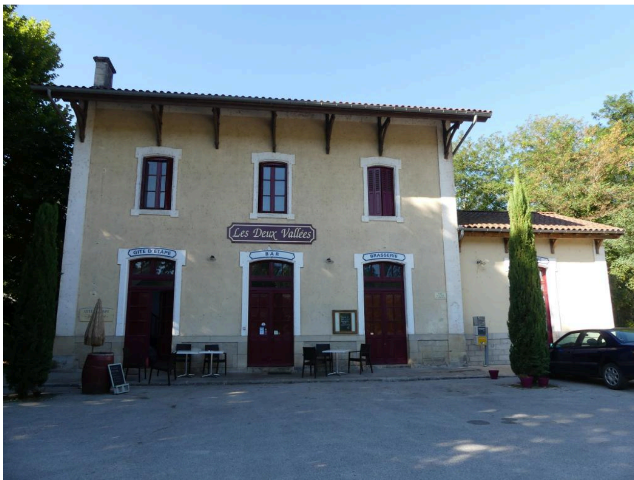
Bâtiment des voyageurs : élévation nord-est.
