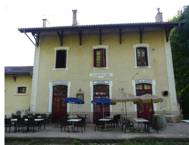
Bâtiment des voyageurs : élévation sud-ouest. Phot. Guillaume Bernard, Phot. Fabien Cadot IVD46_20204602066NUCA
