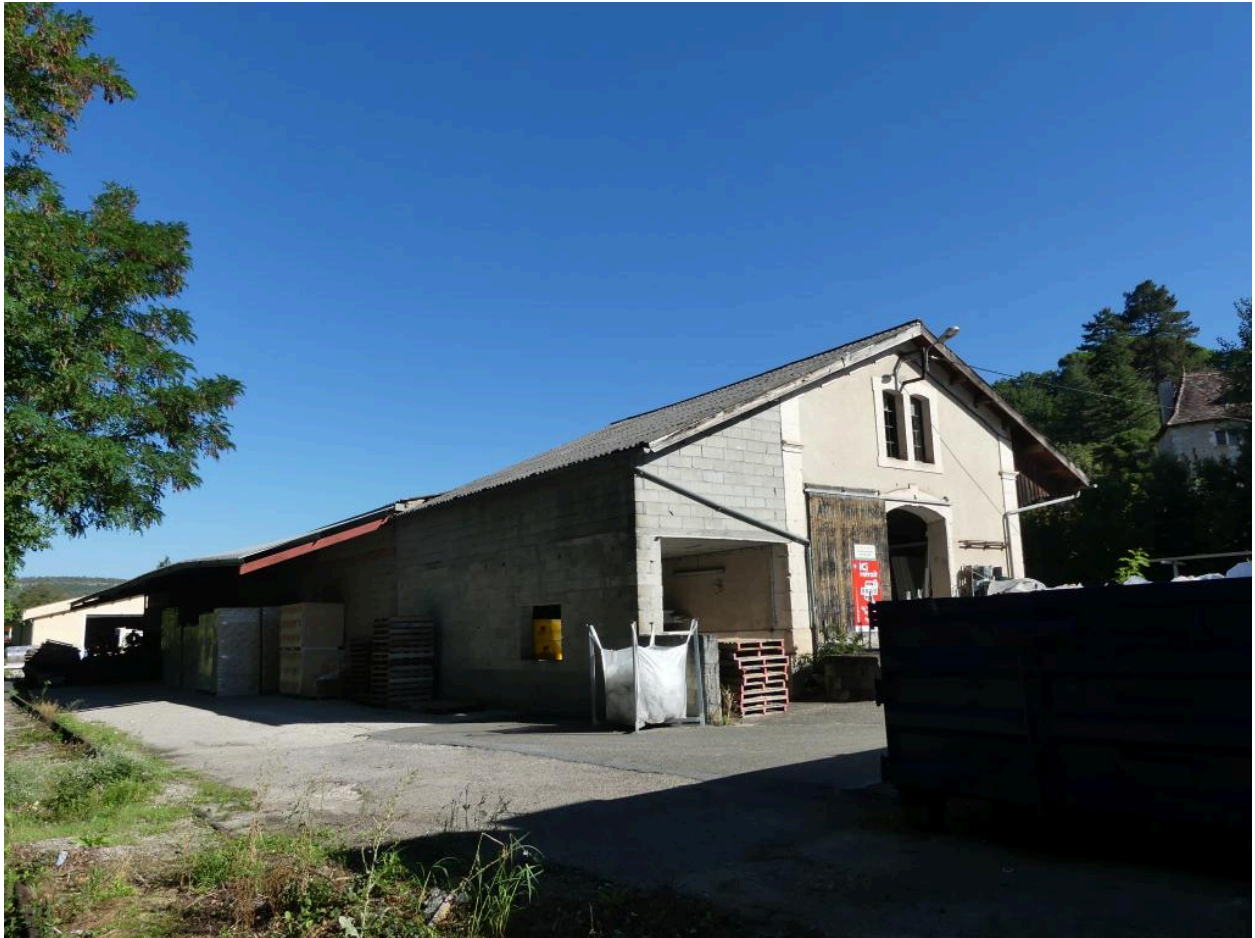
Halles à marchandises : vue depuis le sud.
