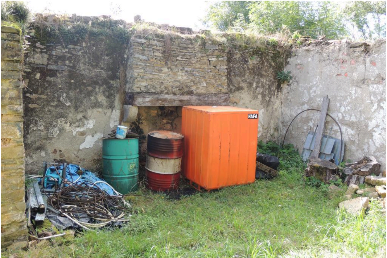
Vue de la cheminée.
