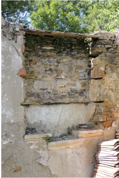
Vue de l'évier. Phot. Marion Fourcayran IVD65_20146500668NUCA
