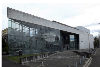
Vue d'ensemble de l'élévation ouest depuis le nord-ouest. Phot. Pauline Bonnefous IVR73_20146501085NUCA
