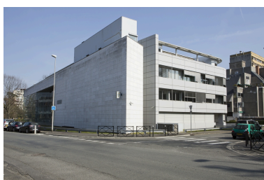
Elévation sud. Phot. Philippe Poitou IVR73_20156551254NUCA
