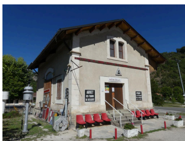
Halles à marchandises : mur-pignon est. Phot. Guillaume Bernard, Phot. Fabien Cadot IVD46_20204602061NUCA
