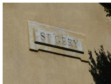
Bâtiment des voyageurs, élévation est : cartouche portant le nom de la station. Phot. Guillaume Bernard, Phot. Fabien Cadot IVD46_20204602053NUCA
