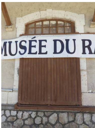
Halles à marchandises, élévation nord : porte. Phot. Guillaume Bernard, Phot. Fabien Cadot IVD46_20204602065NUCA
