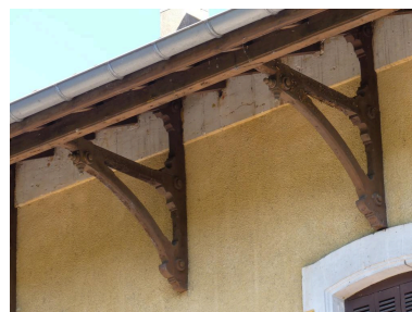
Bâtiment des voyageurs, élévation sud : détail des aisseliers. Phot. Guillaume Bernard, Phot. Fabien Cadot IVD46_20204602057NUCA
