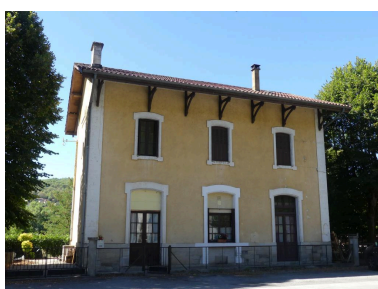
Bâtiment des voyageurs : élévation nord. Phot. Guillaume Bernard, Phot. Fabien Cadot IVD46_20204602052NUCA
