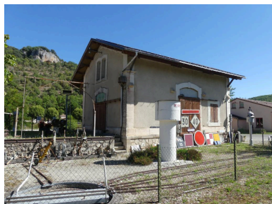
Halles à marchandises, vue depuis le sud. Phot. Guillaume Bernard, Phot. Fabien Cadot IVD46_20204602051NUCA
