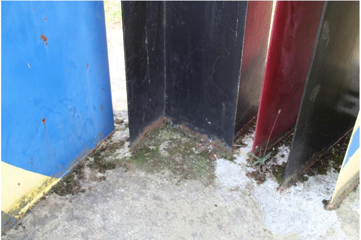
détail de l'oeuvre : implantation des lames d'acier dans le socle de béton
