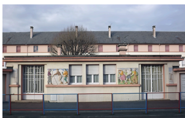
Vue d'ensemble de face. Phot. Roland Chabbert IVR73_20146501038NUCA
