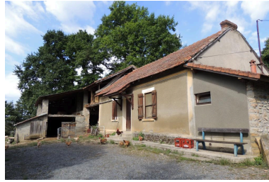
Vue de la ferme depuis le sud-est. Phot. Marion Fourcayran IVD65_20146500021NUCA
