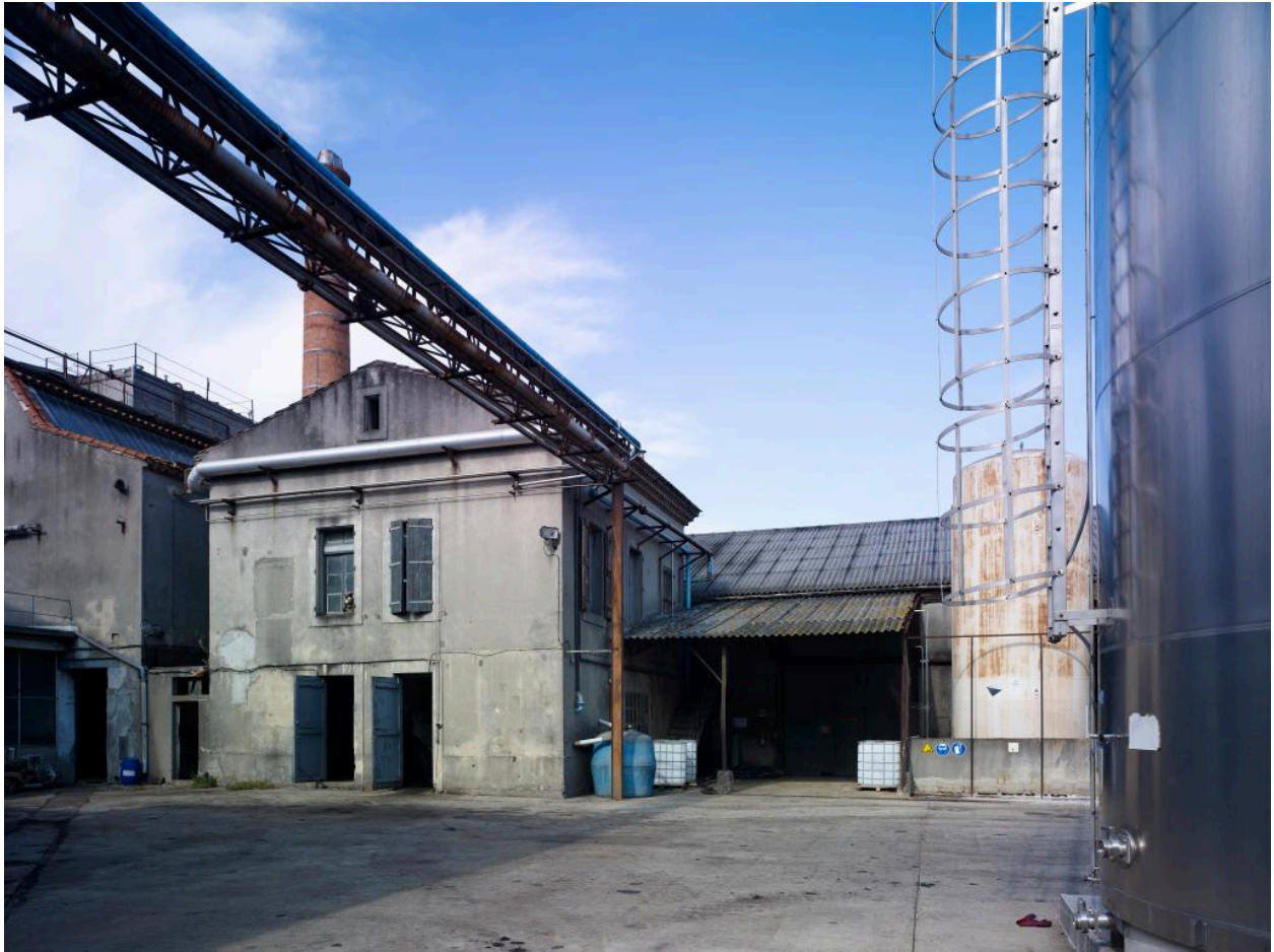
Corps de bâtiments sur cour (bâtiment ayant abrité l'huilerie et la tartrerie).
