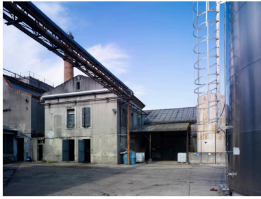
Corps de bâtiments sur cour (bâtiment ayant abrité l'huilerie et la tarterrie). Phot. Marc Kérignard IVR91_20093400442NUC4A
