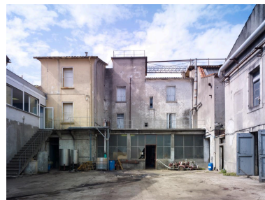
Corps de bâtiments sur cour. Phot. Marc Kérignard IVR91_20093400436NUC4A
