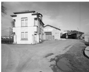
Vue rapprochée de l'élévation sud. Phot. Jean-Michel Périn IVR91_19971100011X
