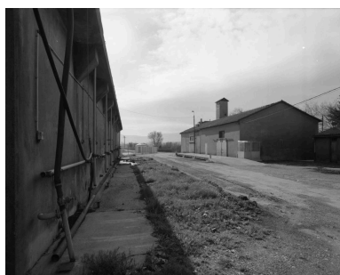
Détail du bâtiment de production avec la tour de la colonne de distillation. Phot. Jean-Michel Périn IVR91_19971100015X
