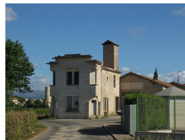
Vue de l'élévation de la distillerie portant inscription. Phot. Michel Wienin IVR91_20111102785NUC1A
