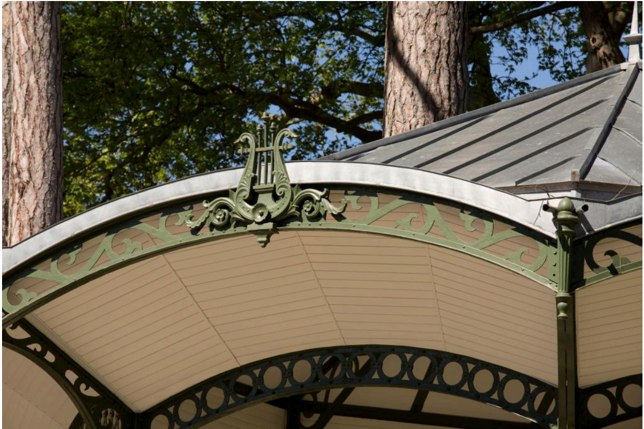
Toiture du kiosque : détail des berceaux lambrissés du pourtour.
