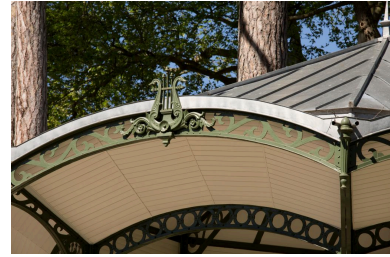
Toiture du kiosque : détail des berceaux lambrissés du pourtour. Phot. Philippe Poitou IVR73_20156551065NUCA
