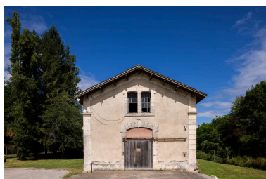
Halle à marchandises, vue depuis l'ouest. Phot. Amélie Boyer IVR76_20244650220NUCA
