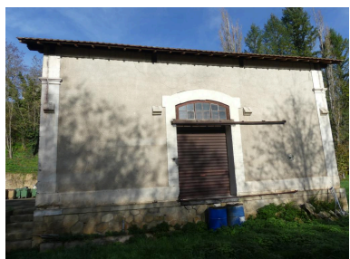
Halles à marchandises : élévation sud-est. Phot. Guillaume Bernard, Phot. Fabien Cadot IVD46_20214605576NUCA
