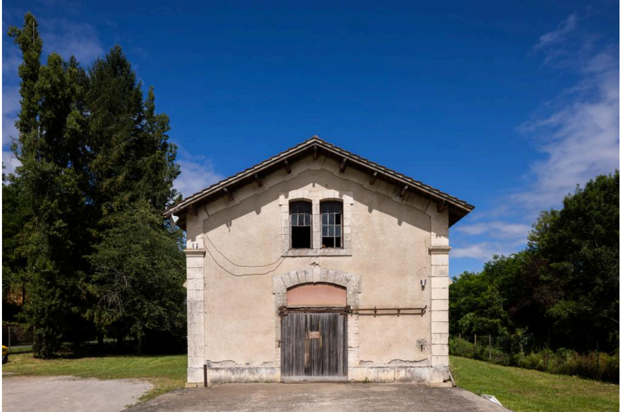
Halle à marchandises, vue depuis l'ouest.
