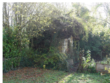
Toilettes-lampisterie : vue le nord-ouest. Phot. Guillaume Bernard, Phot. Fabien Cadot IVD46_20214605575NUCA
