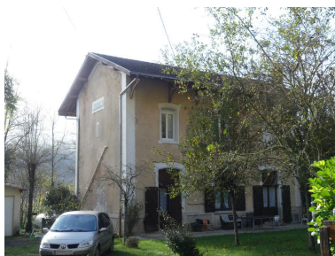
Bâtiment des voyageurs : vue depuis le nord. Phot. Guillaume Bernard, Phot. Fabien Cadot IVD46_20214605574NUCA
