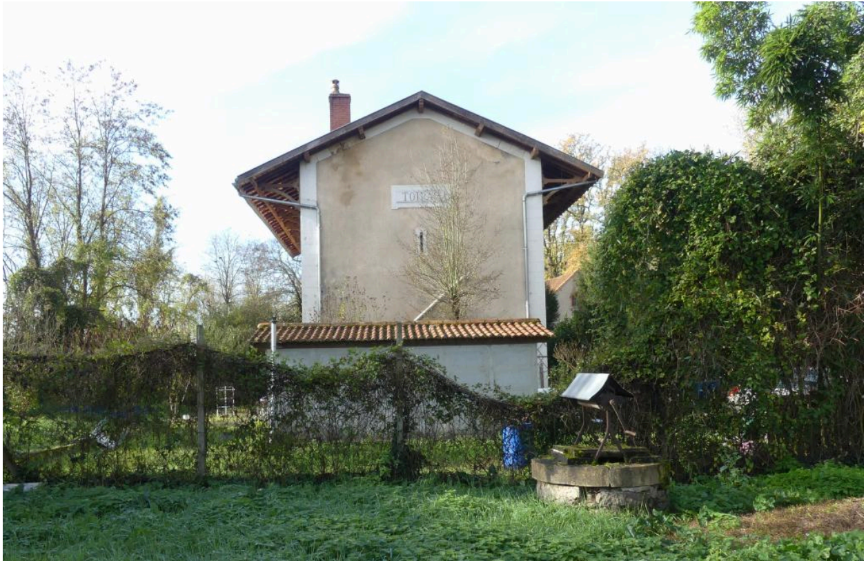
Bâtiment des voyageurs : élévation nord-est.
