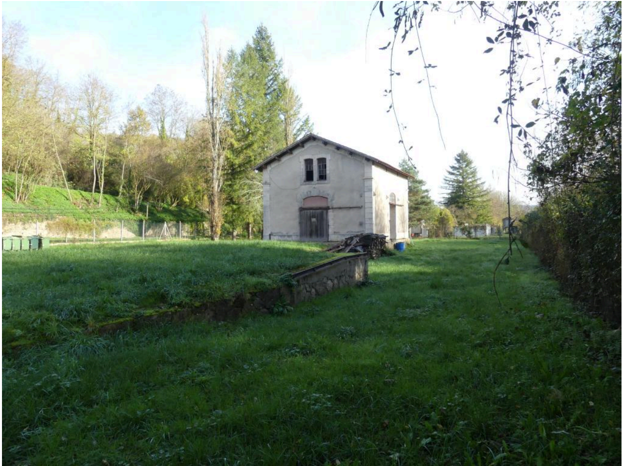
Halles à marchandises : vue depuis le sud-ouest.
