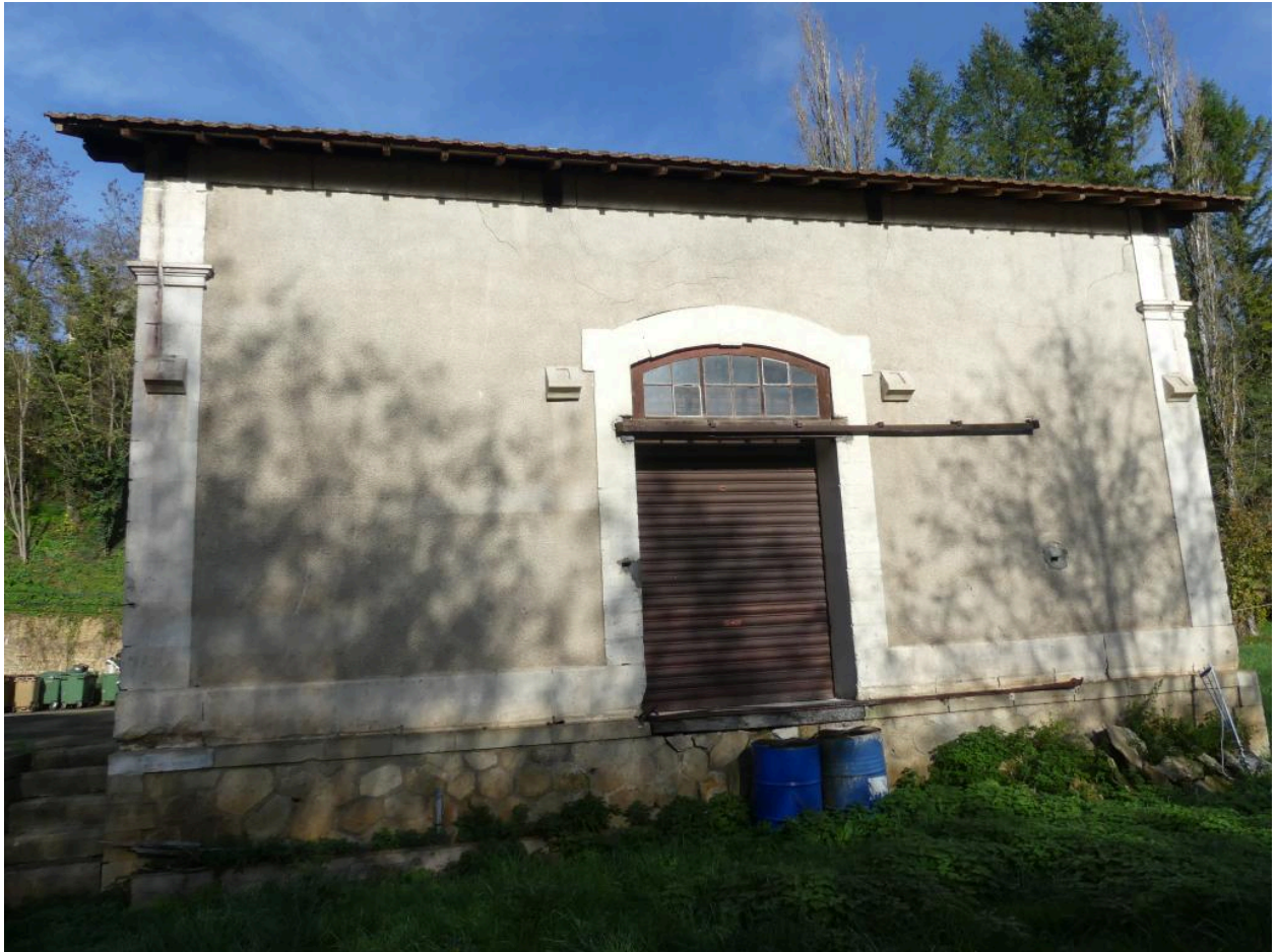
Halles à marchandises : élévation sud-est.
