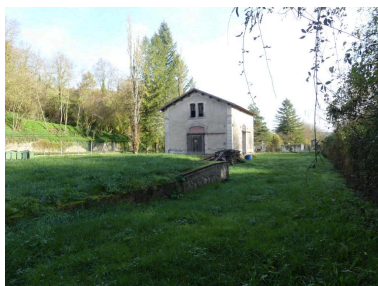
Halles à marchandises : vue depuis le sud-ouest. Phot. Guillaume Bernard, Phot. Fabien Cadot IVD46_20214605581NUCA
