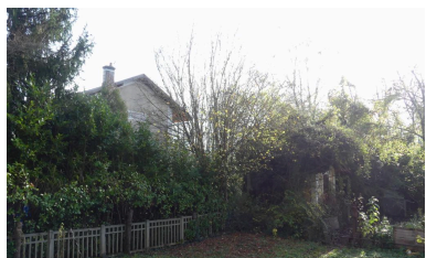
Toilettes-lampisterie : vue depuis la voie au nord-ouest. Phot. Guillaume Bernard, Phot. Fabien Cadot IVD46_20214605579NUCA
