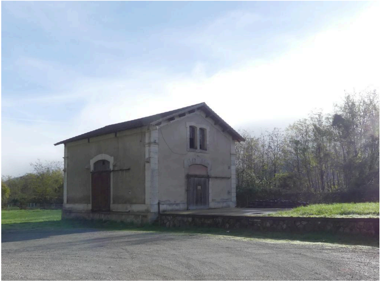
Halles à marchandises : vue depuis le nord-ouest.
