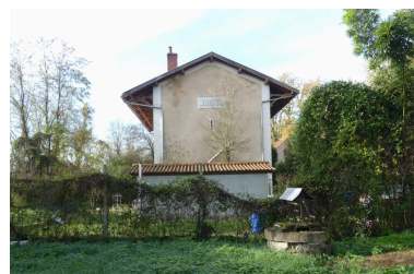
Bâtiment des voyageurs : élévation nord-est. Phot. Guillaume Bernard, Phot. Fabien Cadot IVD46_20214605580NUCA
