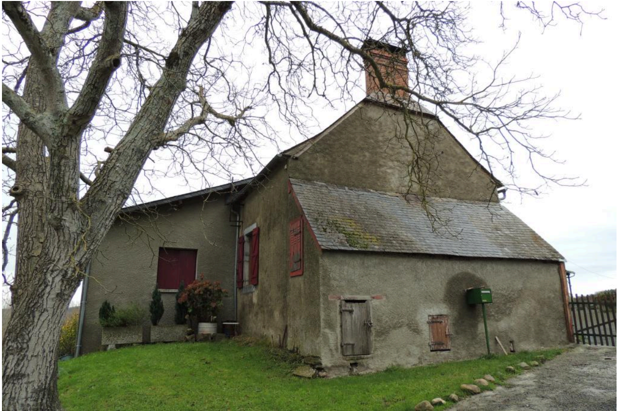
Ferme au lieu-dit Granttes, vue de l'élévation sud-ouest.
