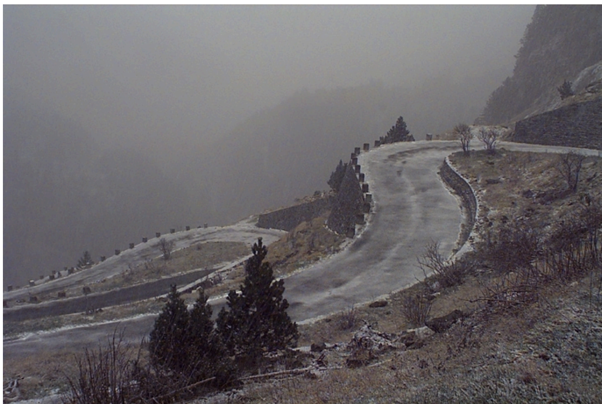
Route en lacets vers le tunnel d'Aragnouet-Bielsa.
