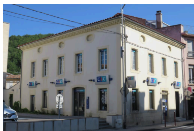
Elévations sud-ouest et sud-est, donnant sur rue. Phot. Lucas Destrem IVC09160_20180901041NUCA
