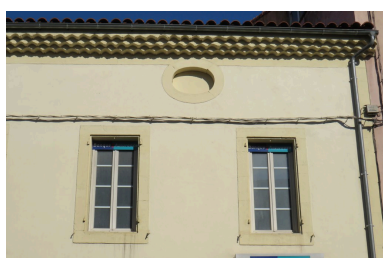
Elévation sud-est, donnant sur rue, détail. Phot. Lucas Destrem IVC09160_20180901040NUCA
