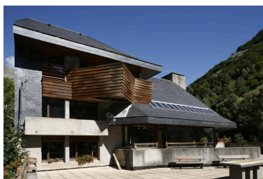
La Maison du Parc : façade donnant sur la terrasse au sud. Phot. Philippe Poitou IVR73_20116554345NUCA
