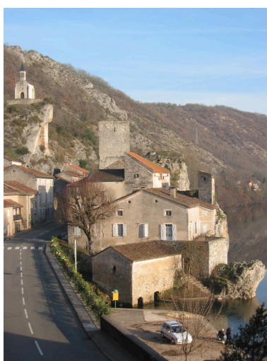
Vue générale de la chapelle Saint-Roch et du château (donjon et pigeonnier) Phot. Nicolas Bru IVD46_20034601104NUCA
