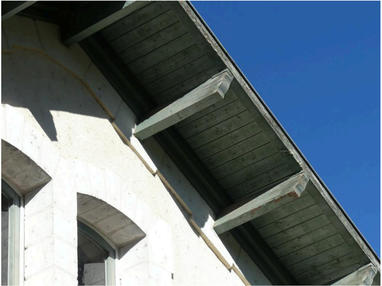
Halles   marchandises,  levation sud-ouest : d tail de la toiture.
