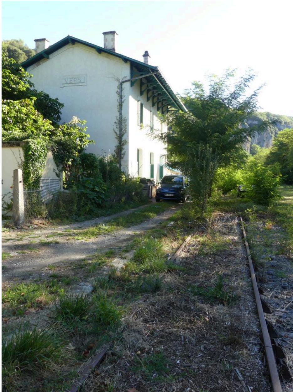
Vue du bâtiment des voyageurs depuis le sud-ouest.
