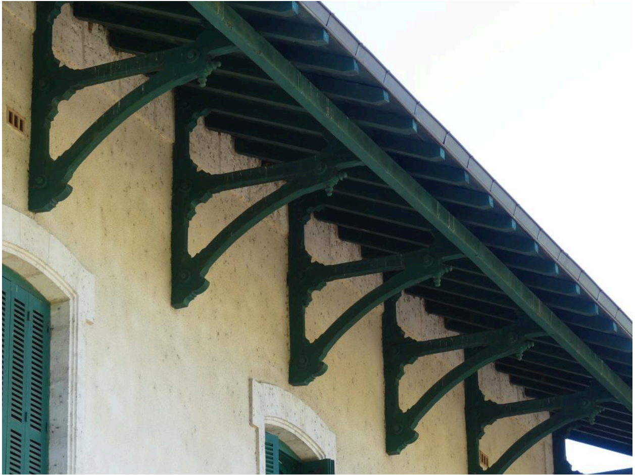
B timent des voyageurs,  l vation nord-ouest : d tail de la charpente.
