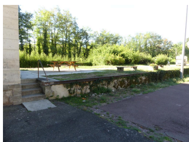
Halles à marchandises : quai. Phot. Guillaume Bernard, Phot. Fabien Cadot IVD46_20204602025NUCA
