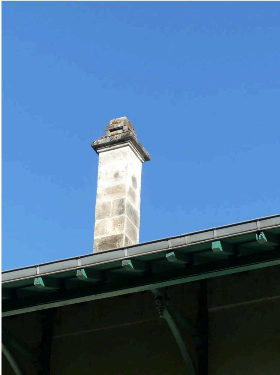
Bâtiment des voyageurs, élévation sud-est : souche de cheminée et détail de la charpente.
