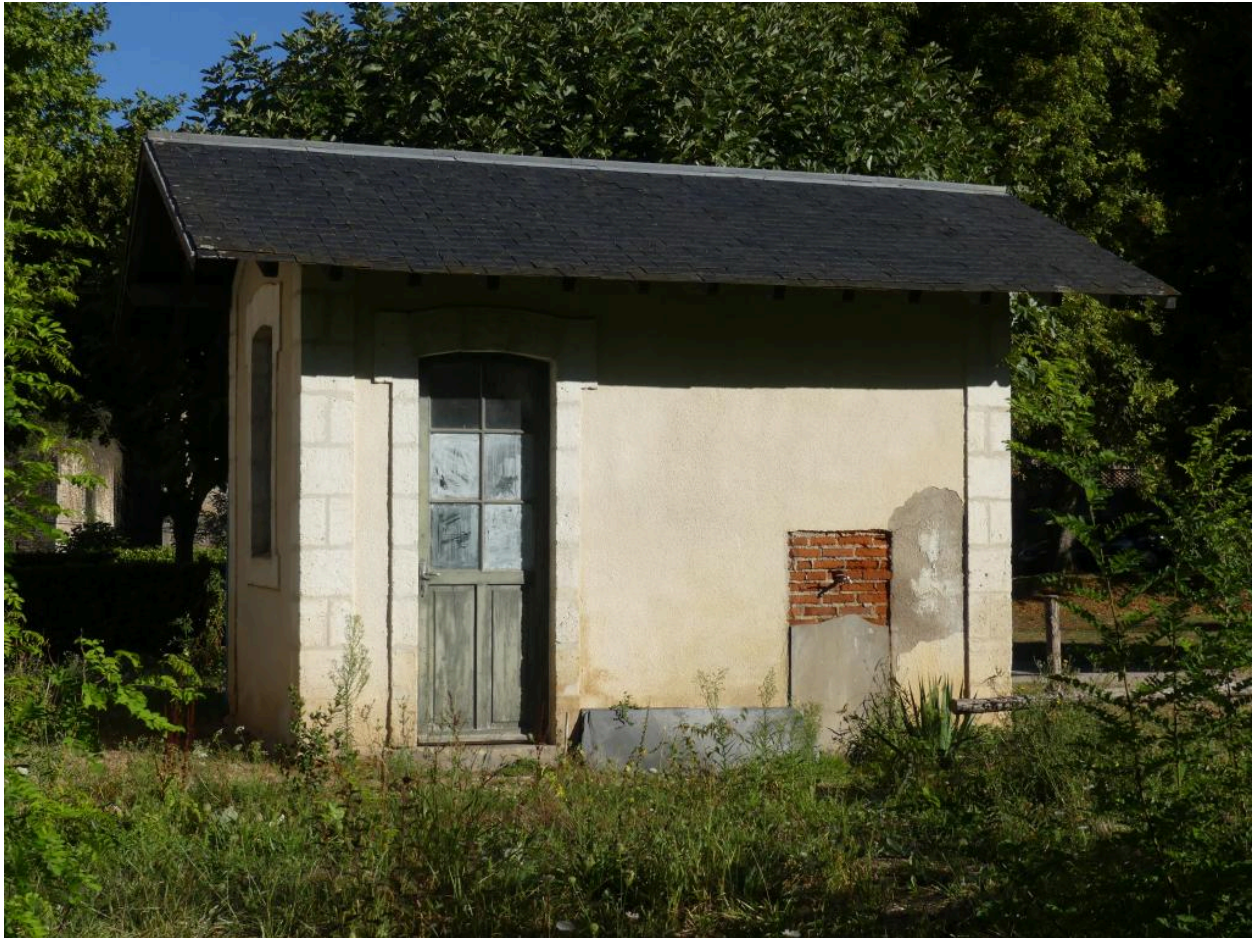
Toilettes,  levation sud-est.
