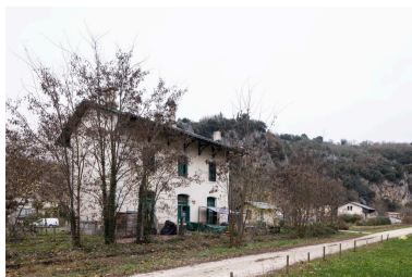
Vue générale depuis le sud-est. Phot. Amélie Boyer IVR76_20234650061NUCA
