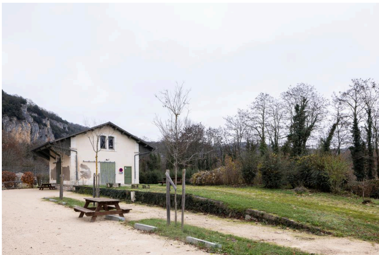
Halle à marchandises, vue depuis le nord-est.
