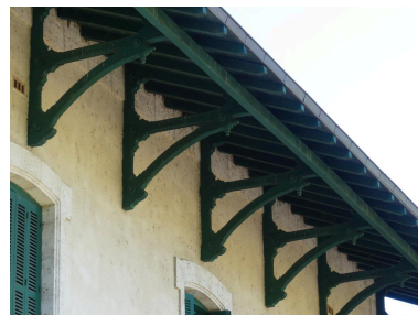
Bâtiment des voyageurs, élévation nord-ouest : détail de la charpente. Phot. Guillaume Bernard, Phot. Fabien Cadot IVD46_20204602027NUCA
