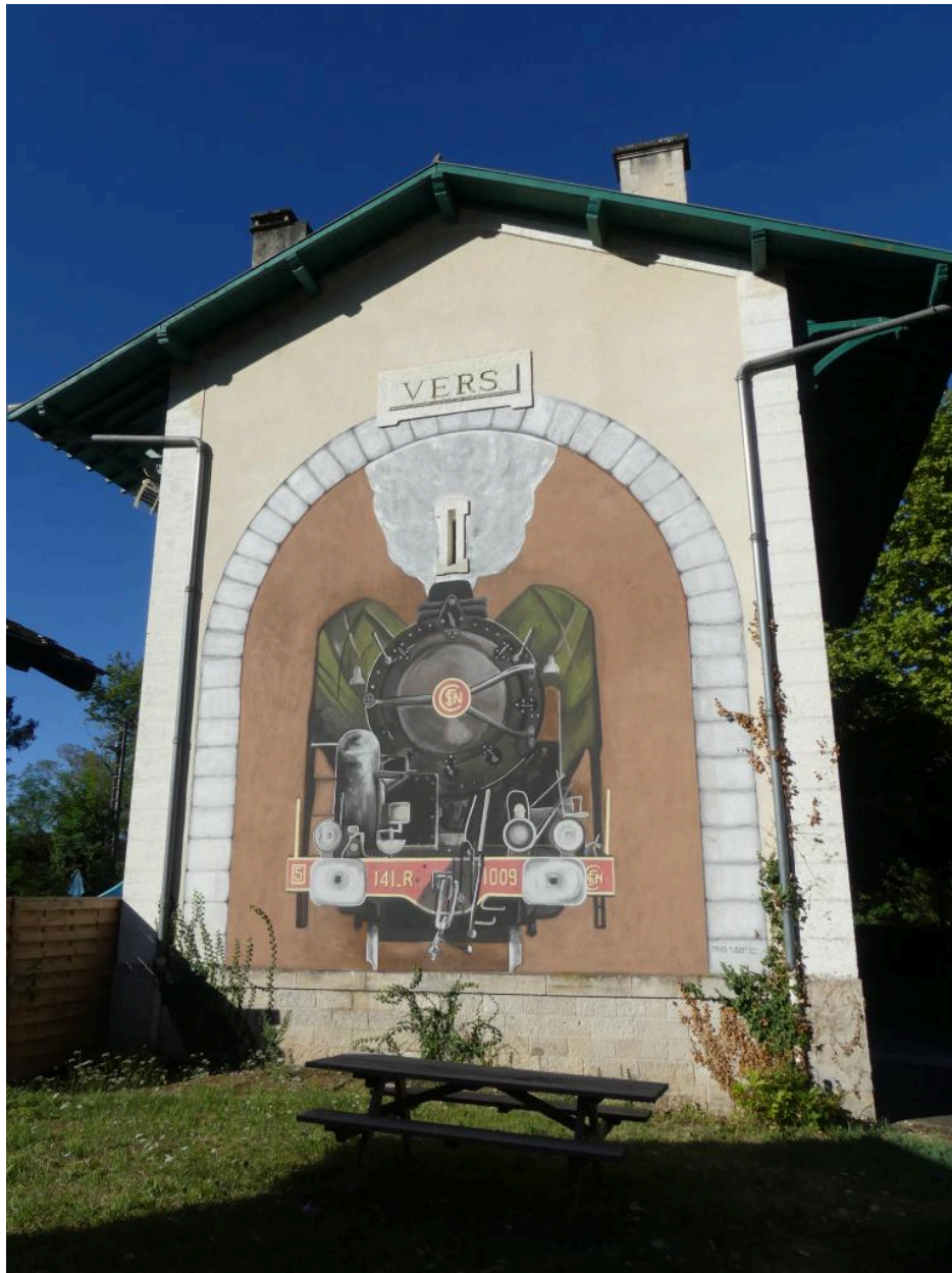
Bâtiment des voyageurs, élévation nord-est : peinture murale représentant une locomotive.
