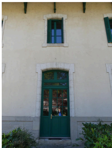
Bâtiment des voyageurs, élévation nord-ouest : ouvertures de la travée centrale. Phot. Guillaume Bernard, Phot. Fabien Cadot IVD46_20204602010NUCA
