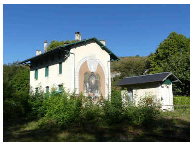
Vue d'ensemble depuis l'est : b timent des voyageurs et toilettes. Phot. Guillaume Bernard, Phot. Fabien Cadot IVD46_20204602020NUCA
