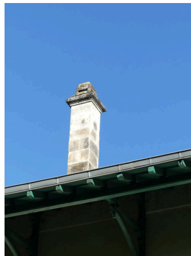
Bâtiment des voyageurs, élévation sud-est : souche de cheminée et détail de la charpente. Phot. Guillaume Bernard, Phot. Fabien Cadot IVD46_20204602026NUCA
