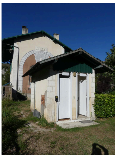
Toilettes, vue de l'est. Phot. Guillaume Bernard, Phot. Fabien Cadot IVD46_20204602019NUCA
