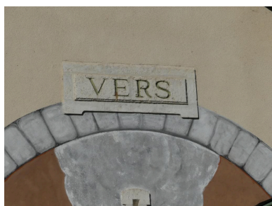
B timent des voyageurs,  levation nord-est : d tail de la peinture murale. Phot. Guillaume Bernard, Phot. Fabien Cadot IVD46_20204602003NUCA
