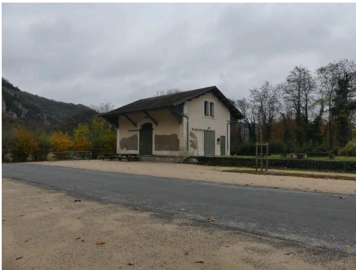
Halles   marchandises : vue depuis le nord-ouest.
