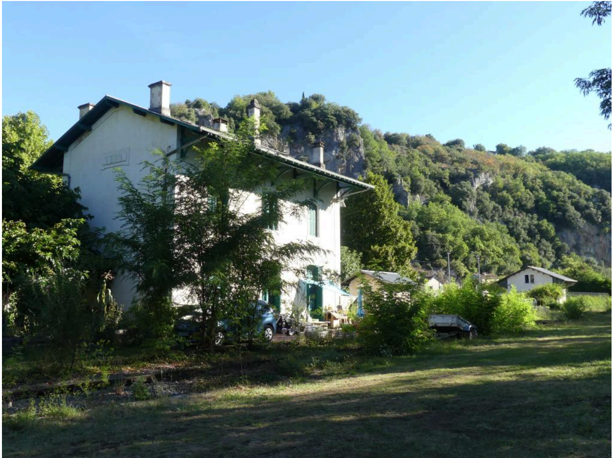
Vue du bâtiment des voyageurs depuis le sud-ouest.
