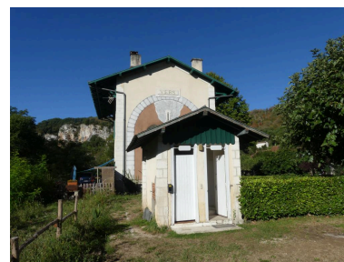
Toilettes, vue depuis l'est. Phot. Guillaume Bernard, Phot. Fabien Cadot IVD46_20204602013NUCA
