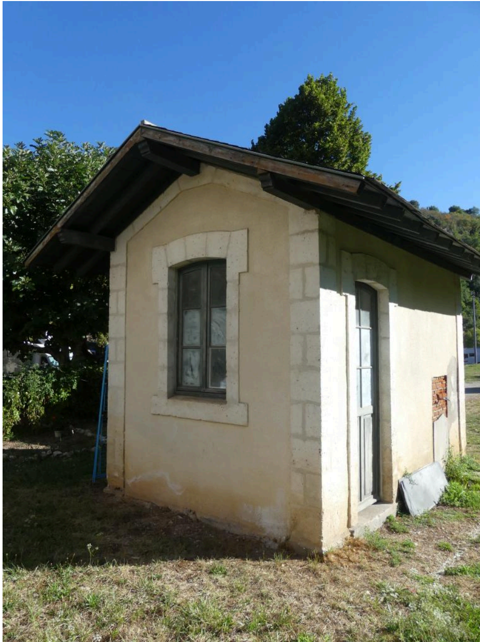
Toilettes, vue du sud-ouest.
