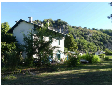
Vue du bâtiment des voyageurs depuis le sud-ouest. Phot. Guillaume Bernard, Phot. Fabien Cadot IVD46_20204602009NUCA
