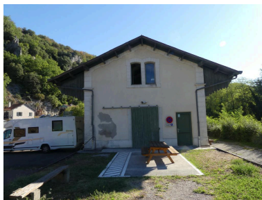
Halles à marchandises : élévation sud-ouest. Phot. Guillaume Bernard, Phot. Fabien Cadot IVD46_20204602014NUCA
