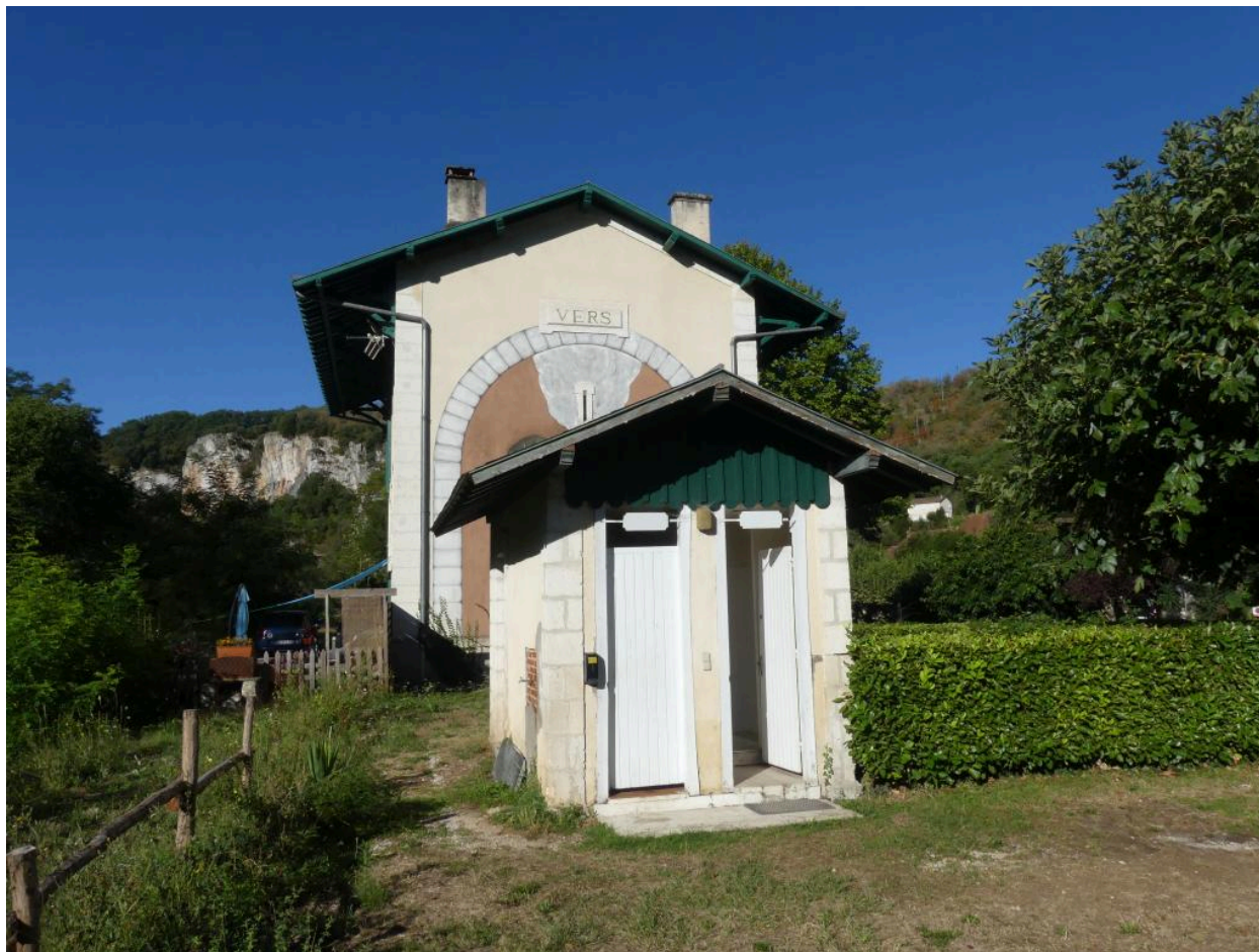
Toilettes, vue depuis l'est.
