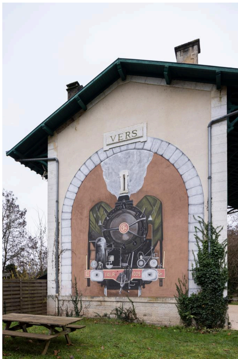
Bâtiment des voyageurs, élévation nord-est.
