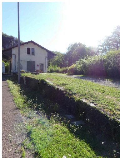
Halles à marchandises : quai. Phot. Guillaume Bernard, Phot. Fabien Cadot IVD46_20204602018NUCA
