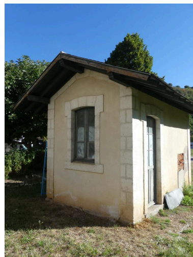
Toilettes, vue du sud-ouest. Phot. Guillaume Bernard, Phot. Fabien Cadot IVD46_20204602022NUCA
