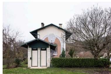
Bâtiment des voyageurs et lampisterie, élévations nord-ouest. Phot. Amélie Boyer IVR76_20234650057NUCA
