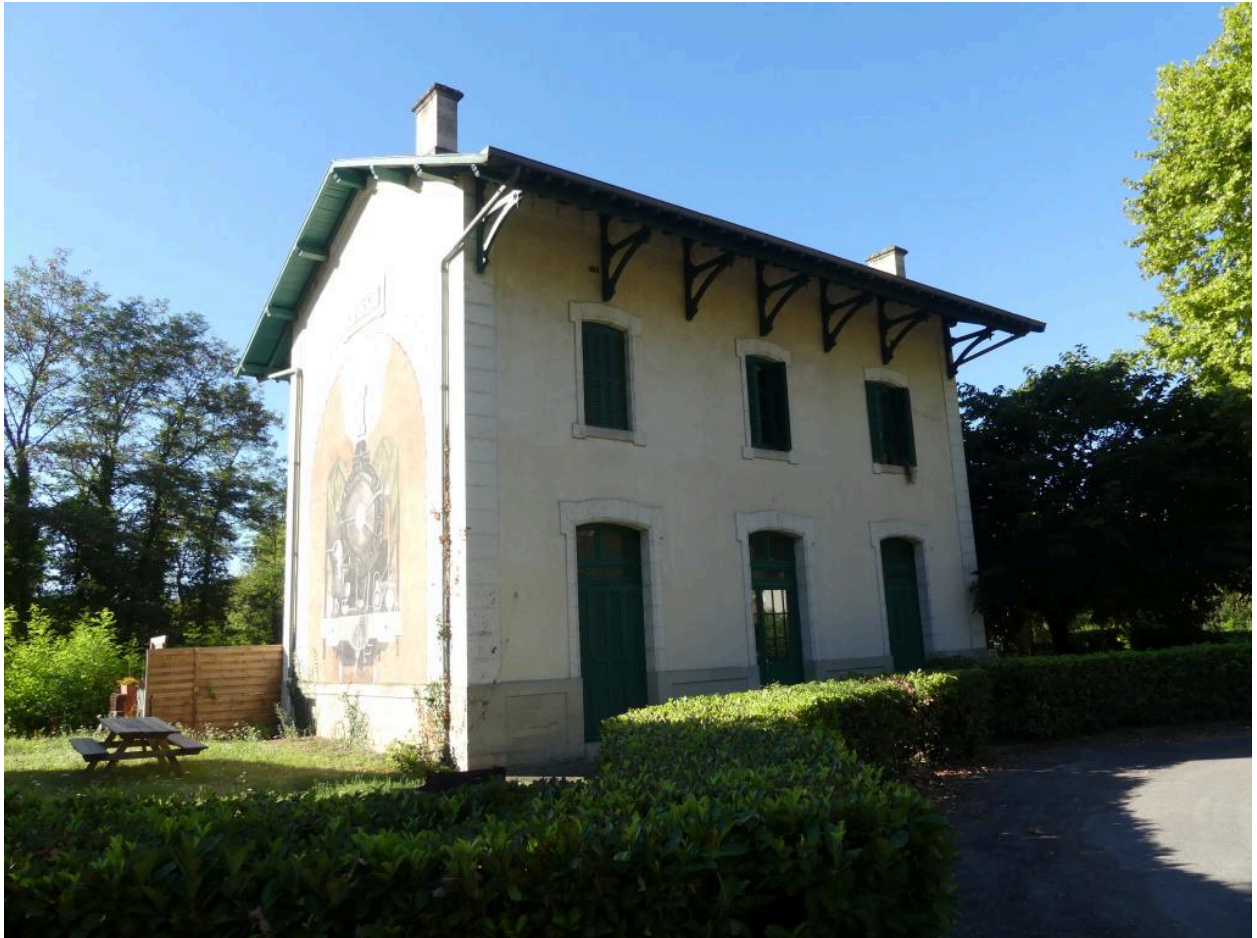
B timent des voyageurs : vue depuis le nord.
