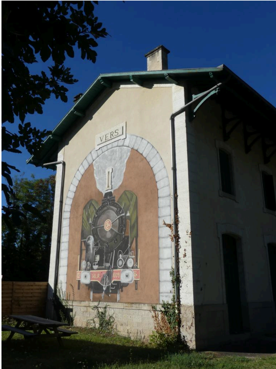
Bâtiment des voyageurs, élévation nord-est.
