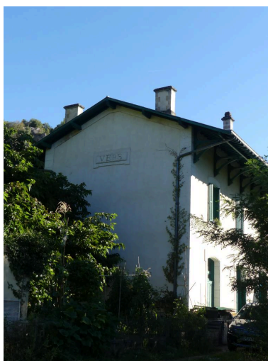
B timent des voyageurs : vue depuis le sud-ouest. Phot. Guillaume Bernard, Phot. Fabien Cadot IVD46_20204602016NUCA
