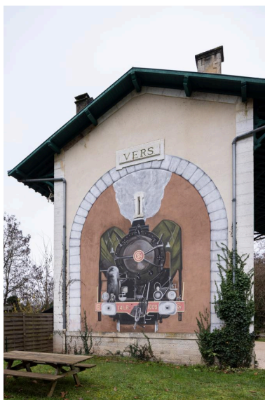
B timent des voyageurs,  l vation nord-est. Phot. Am lie Boyer IVR76_20234650058NUCA
