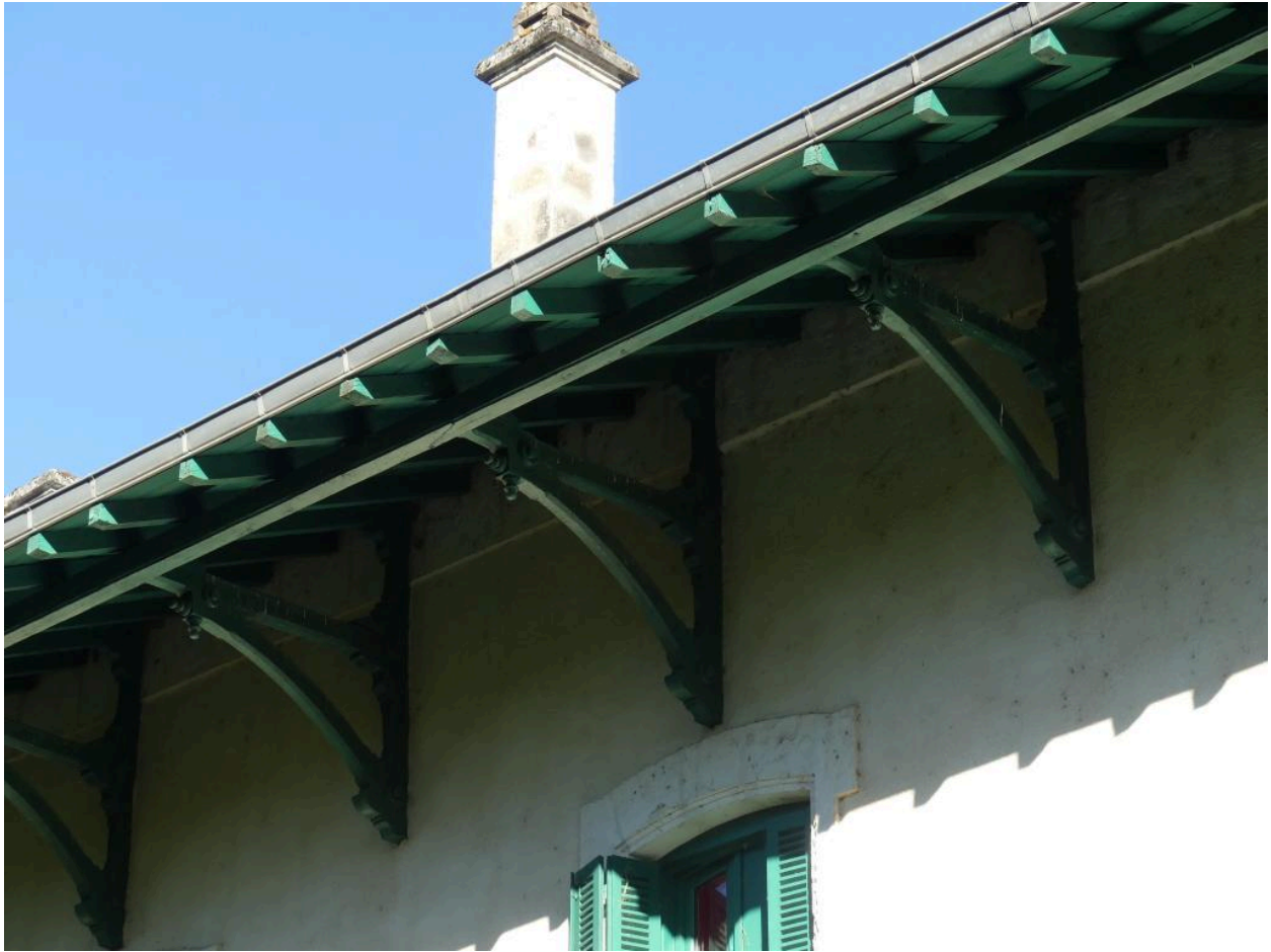
B timent des voyageurs,  l vation sud-est : d tail de la charpente.
