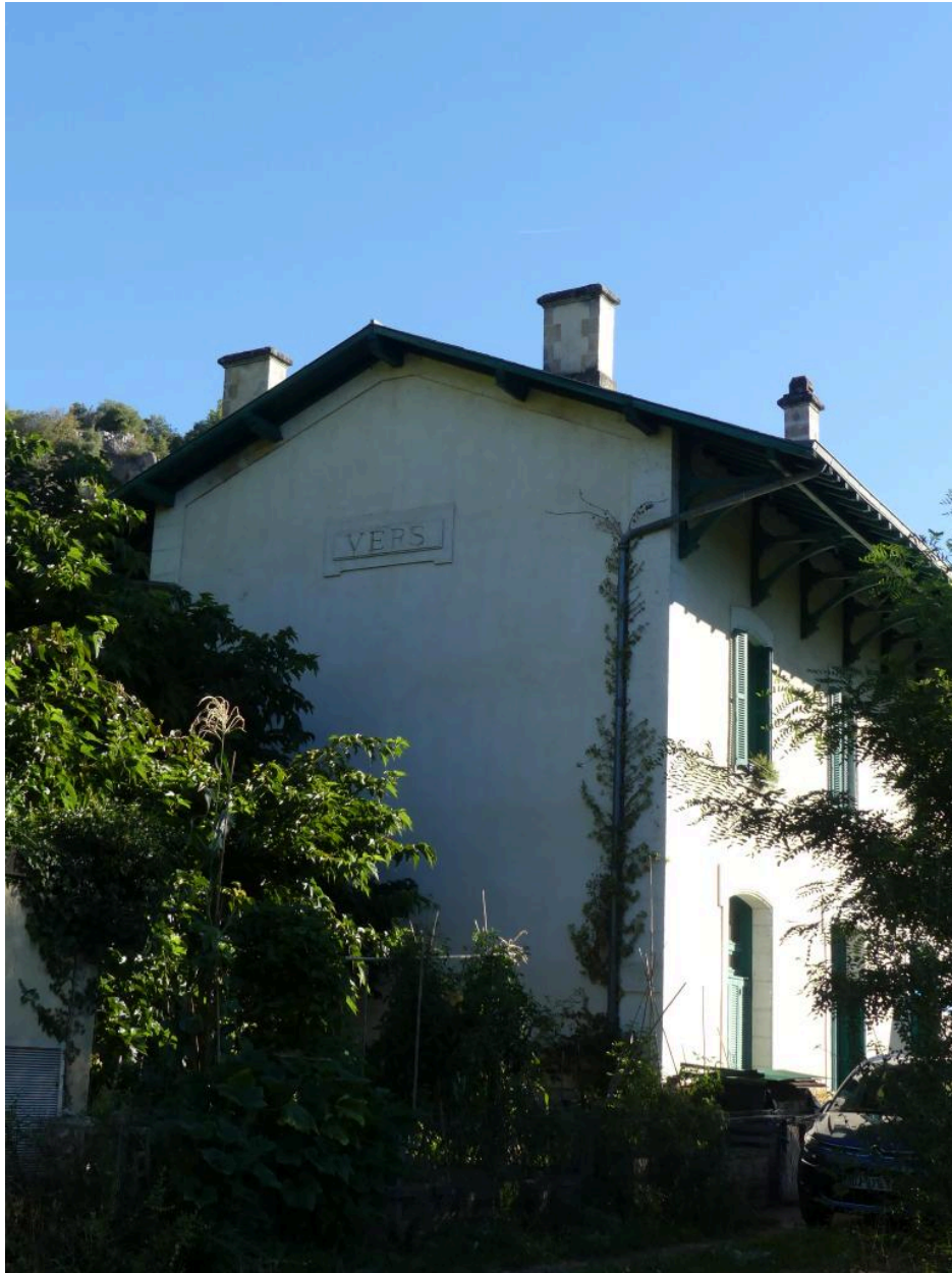
B timent des voyageurs : vue depuis le sud-ouest.
