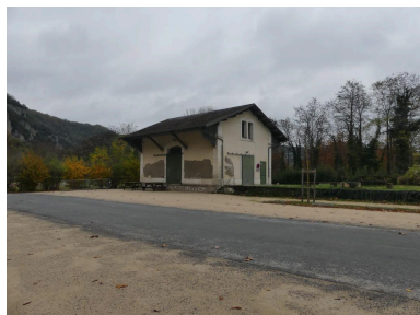
Halles à marchandises : vue depuis le nord-ouest. Phot. Cadot Fabien IVD46_20234600524NUCA
