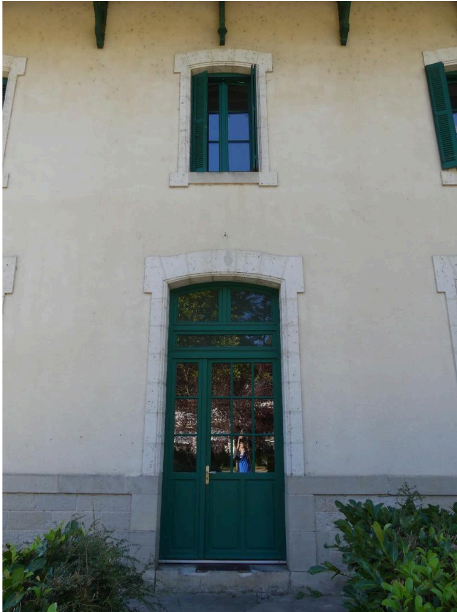
Bâtiment des voyageurs, élévation nord-ouest : ouvertures de la travée centrale.
