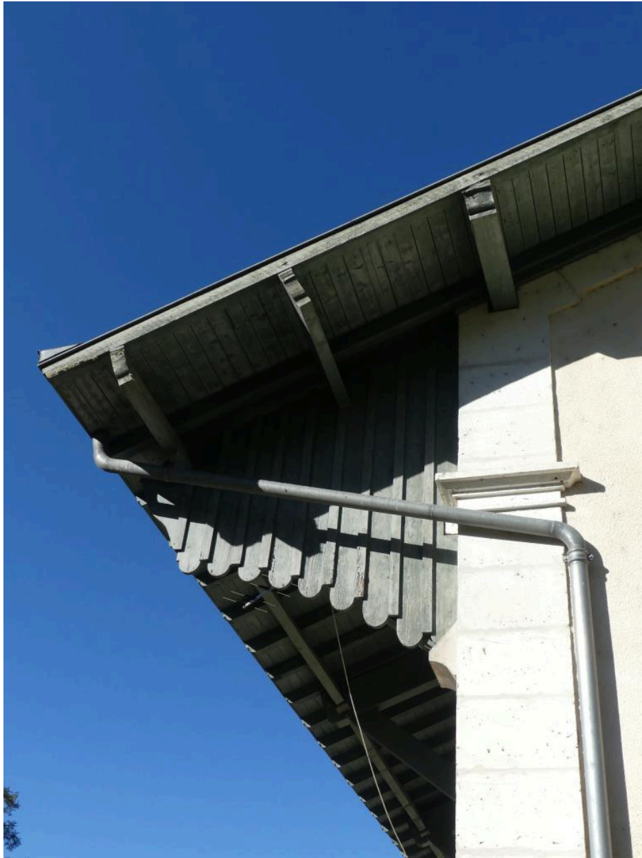
Halles à marchandises, élévation sud-ouest : détail de la charpente.
