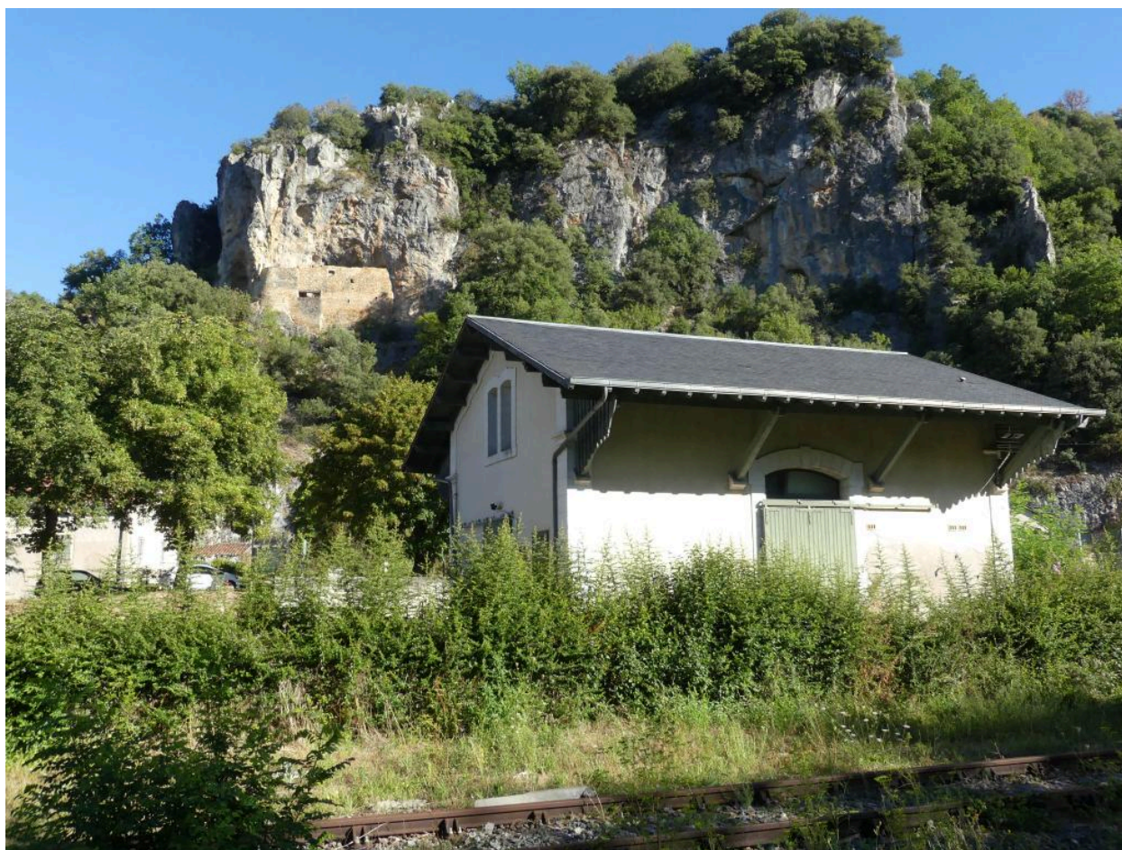
Halles à marchandises, vue depuis le sud.
