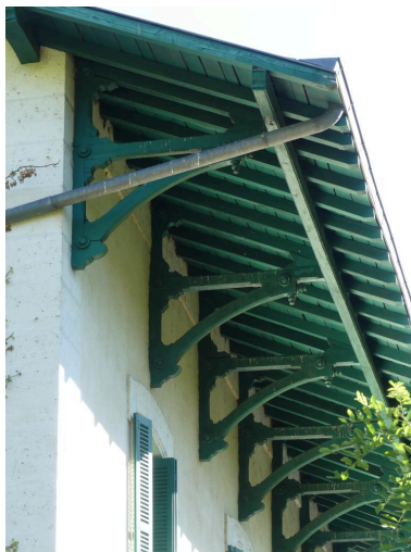
Bâtiment des voyageurs, détail de la charpente de l'élévation sud-est. Phot. Guillaume Bernard, Phot. Fabien Cadot IVD46_20204602004NUCA
