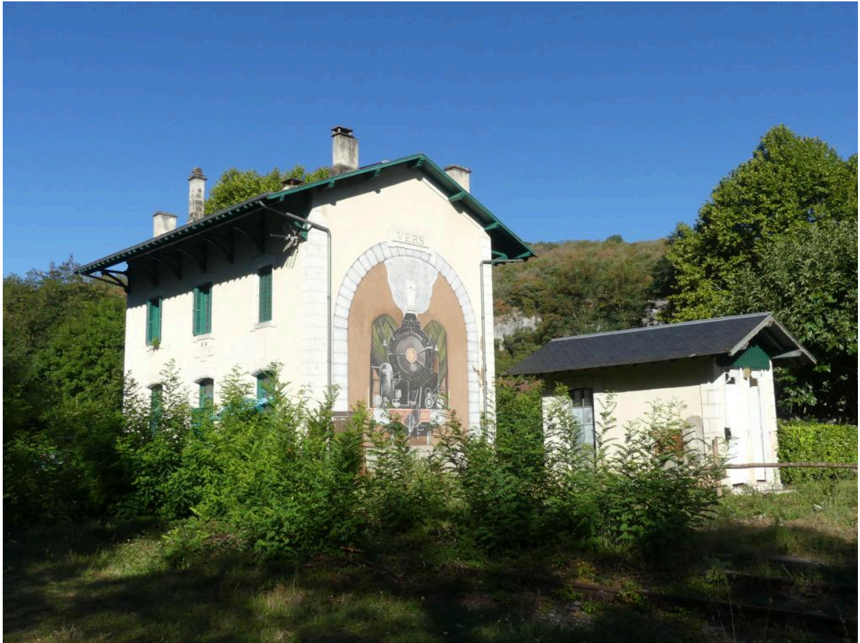
Vue d'ensemble depuis l'est : b timent des voyageurs et toilettes.
