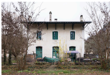
Bâtiment des voyageurs, élévation sud-ouest. Phot. Amélie Boyer IVR76_20234650059NUCA
