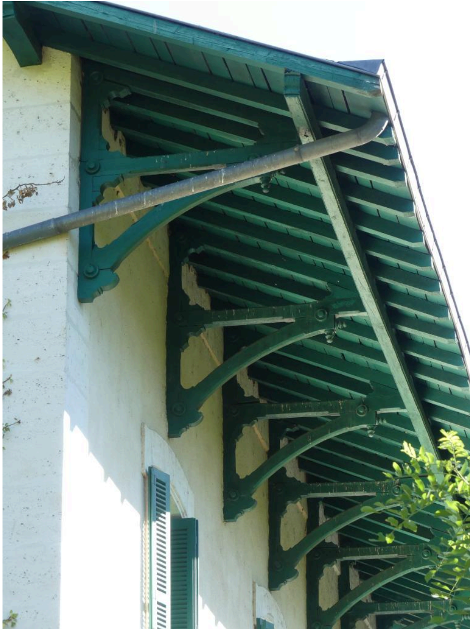
Bâtiment des voyageurs, détail de la charpente de l'élévation sud-est.
