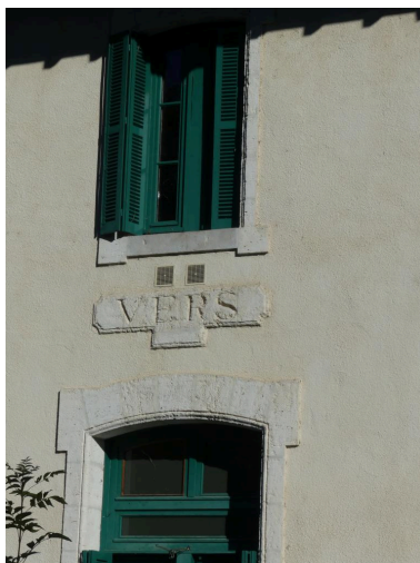
Bâtiment des voyageurs, élévation sud-est : cartouche portant l'inscription "Vers". Phot. Guillaume Bernard, Phot. Fabien Cadot IVD46_20204602006NUCA
