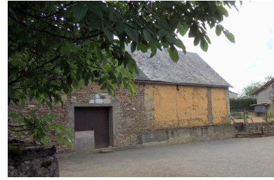
Vue de l'élévation ouest. Phot. Rémi Laffont IVD65_20146500549NUCA
