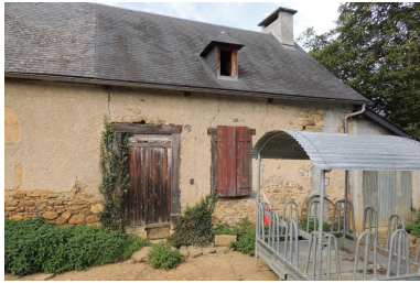
Vue de la partie de la construction dédiée à l'habitation depuis l'est. Phot. Rémi Laffont IVD65_20146500547NUCA
