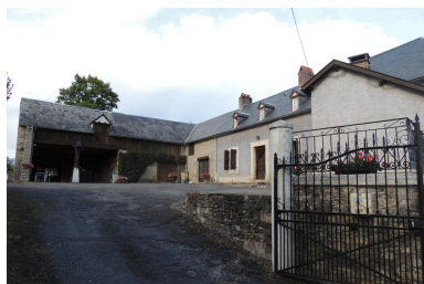
Vue de la ferme depuis le nord. Phot. Rémi Laffont IVD65_20146500506NUCA
