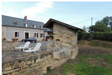
Vue du puits et de l'abreuvoir. Phot. Rémi Laffont IVD65_20146500509NUCA
