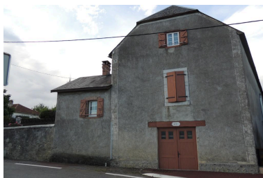
Vue de l'élévation nord de la ferme. Phot. Rémi Laffont IVD65_20146500505NUCA
