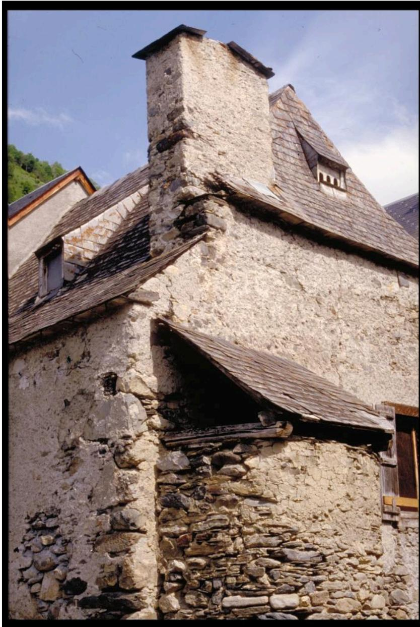
Elévation latérale sur la rue, avec le four saillant.
