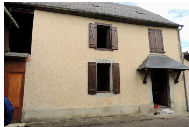
Vue de l'élévation principale de l'habitation depuis le sud. Phot. Marion Fourcayran IVD65_20136500136NUCA
