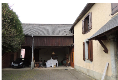
Vue des dépendances depuis l'est. Phot. Marion Fourcayran IVD65_20136500139NUCA
