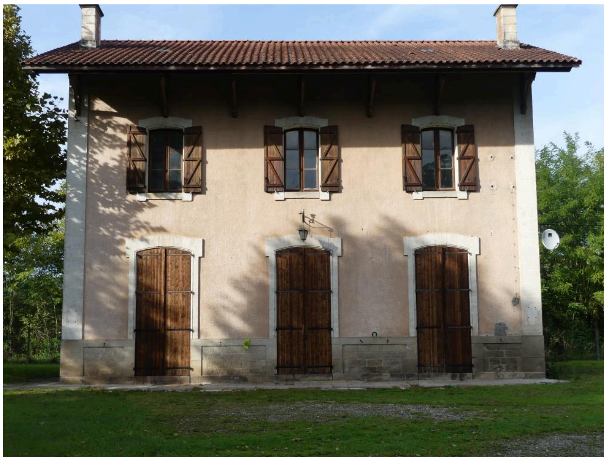
Bâtiment des voyageurs, élévation sud.
