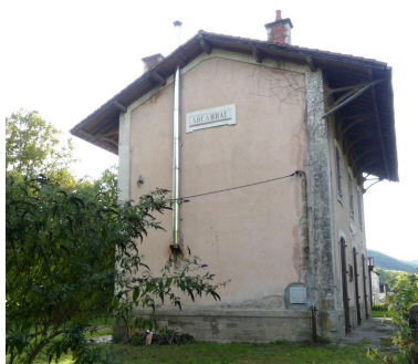
Bâtiment des voyageurs, élévation est. Phot. Guillaume Bernard, Phot. Fabien Cadot IVD46_20204602113NUCA
