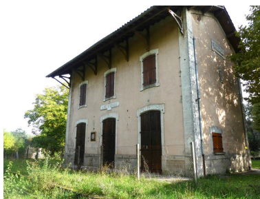
Bâtiment des voyageurs, vue depuis l'ouest. Phot. Guillaume Bernard, Phot. Fabien Cadot IVD46_20204602115NUCA
