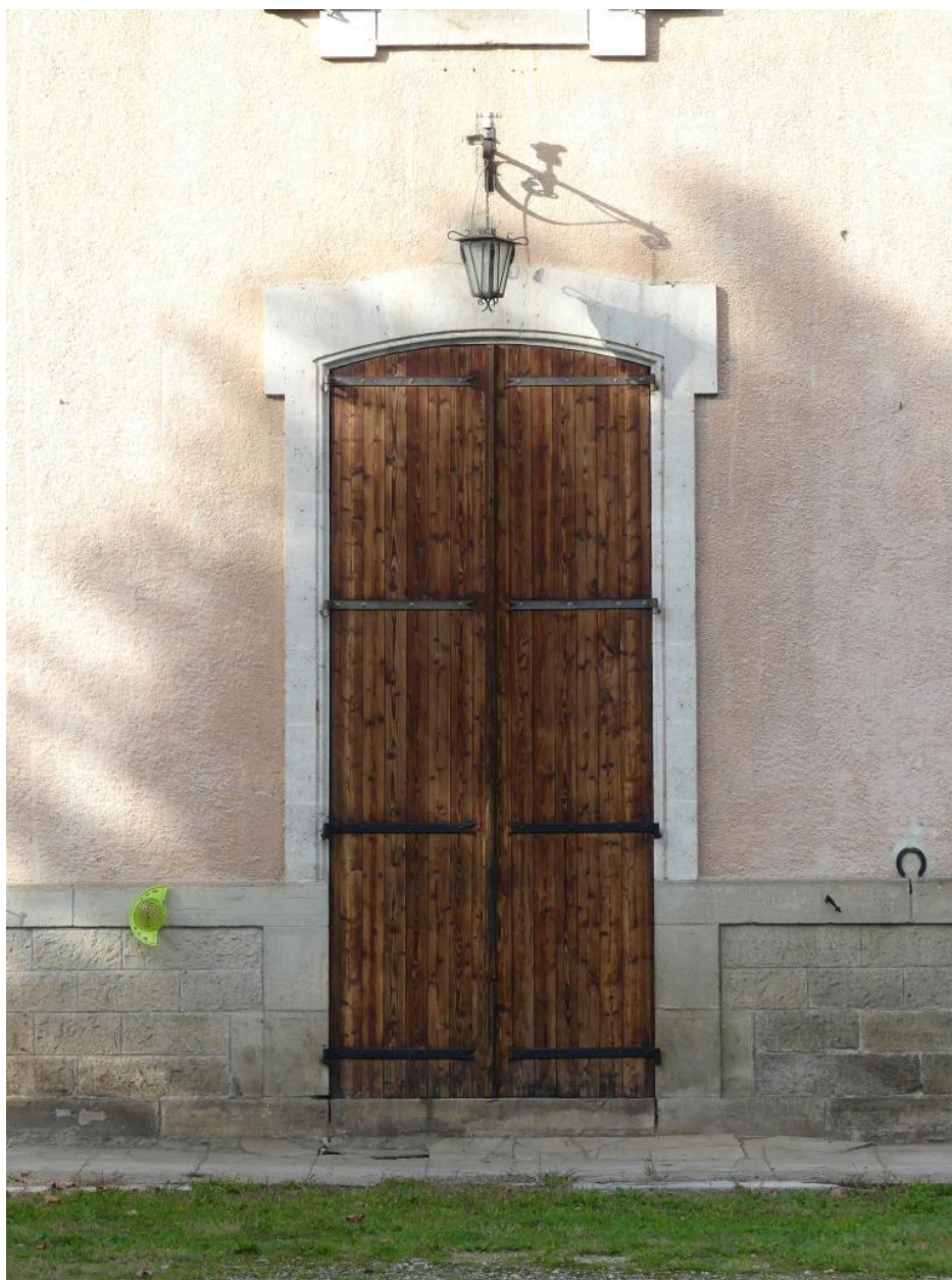
Bâtiment des voyageurs, élévation sud : porte centrale.
