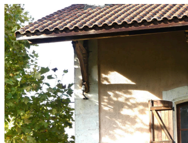
Bâtiment des voyageurs, élévation nord : détail du débord de toit.. Phot. Guillaume Bernard, Phot. Fabien Cadot IVD46_20204602112NUCA
