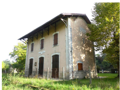
Bâtiment des voyageurs, vue depuis l'ouest. Phot. Guillaume Bernard, Phot. Fabien Cadot IVD46_20204602121NUCA
