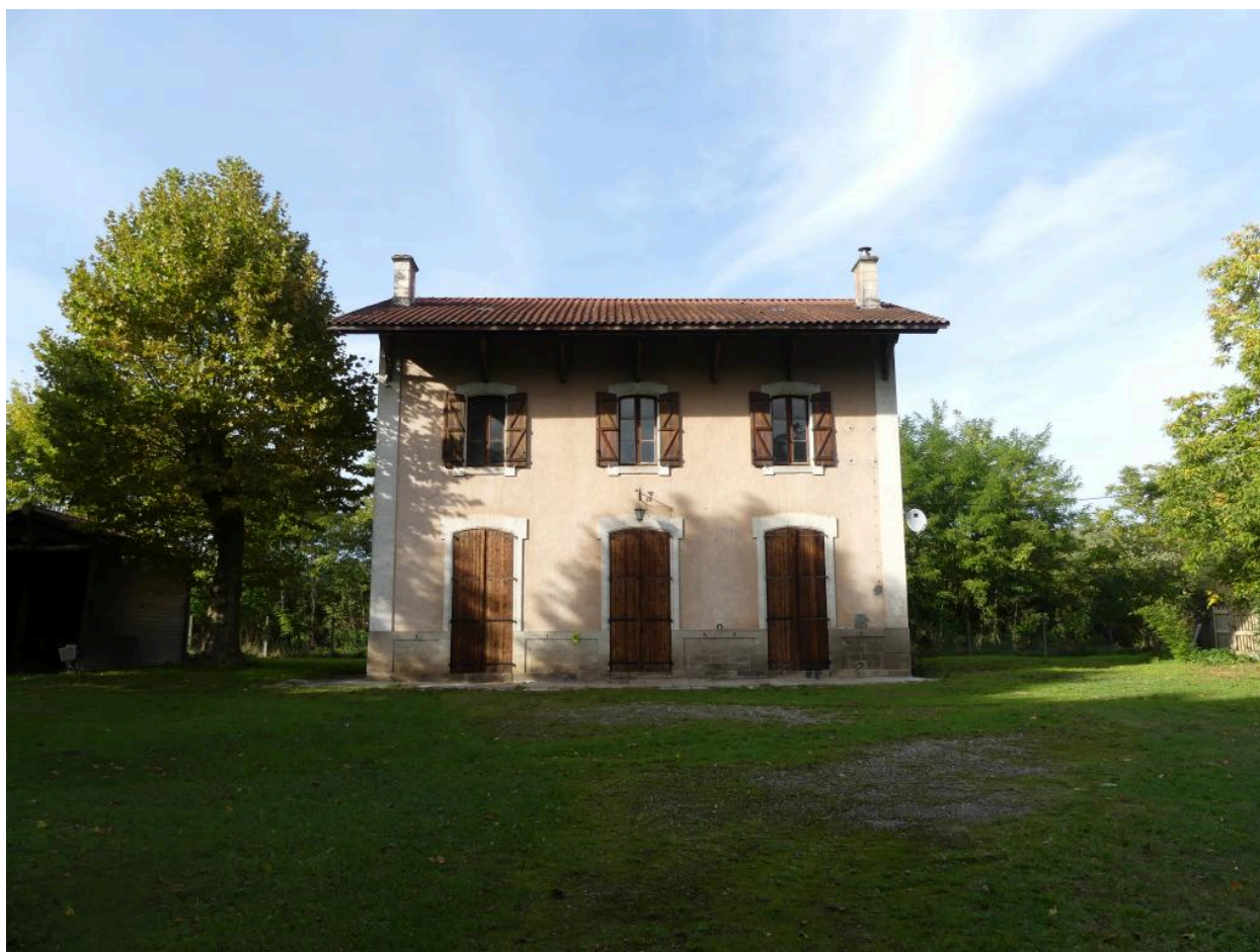
Bâtiment des voyageurs, élévation sud.
