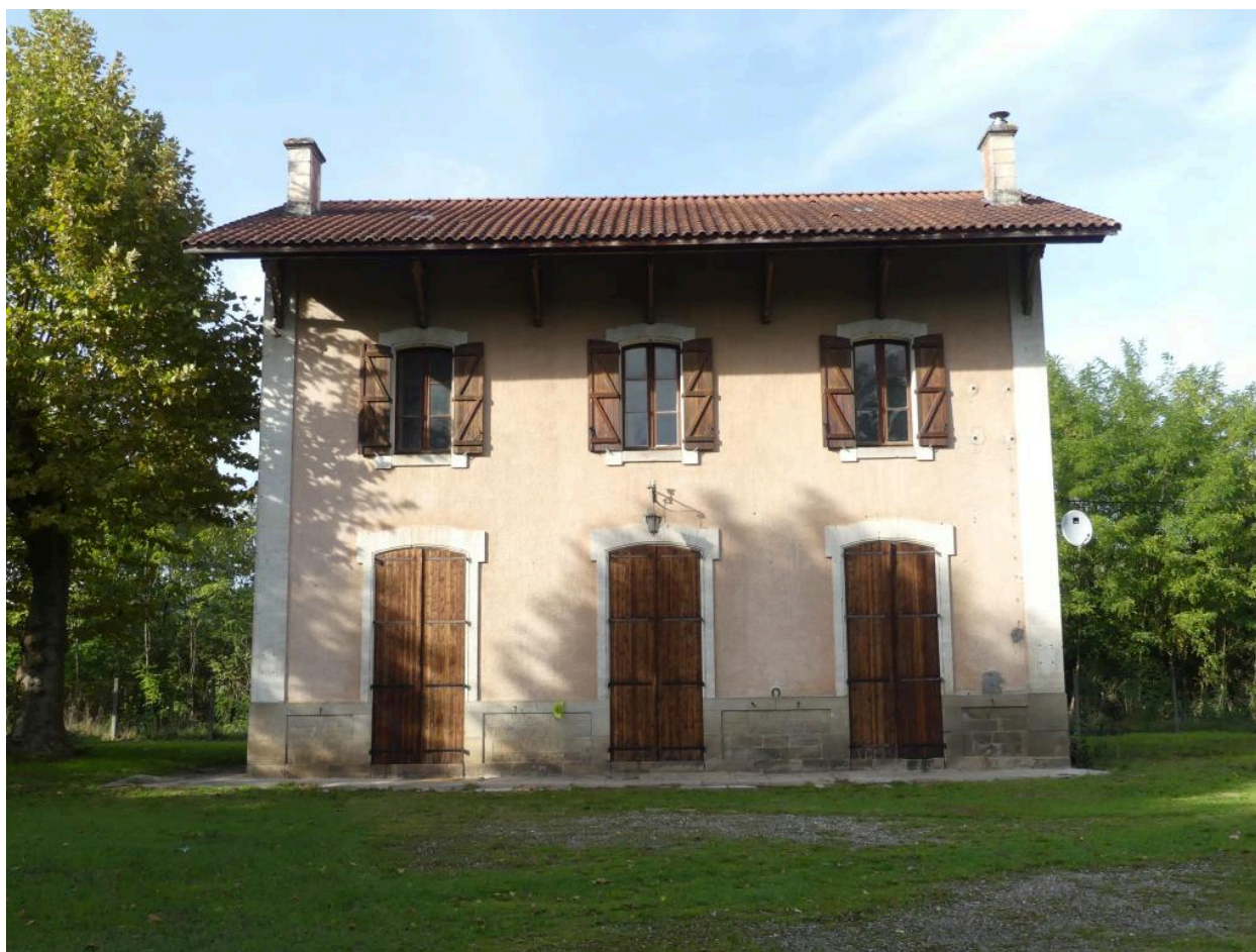
Bâtiment des voyageurs, élévation sud.
