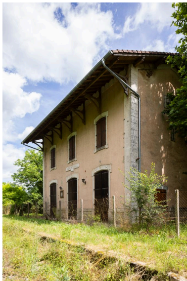
Vue depuis la voie. Phot. Amélie Boyer IVR76_20244650173NUCA
