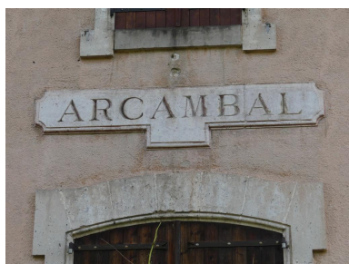
Bâtiment des voyageurs, élévation nord : cartouche indiquant le nom de la gare. Phot. Guillaume Bernard, Phot. Fabien Cadot IVD46_20204602116NUCA
