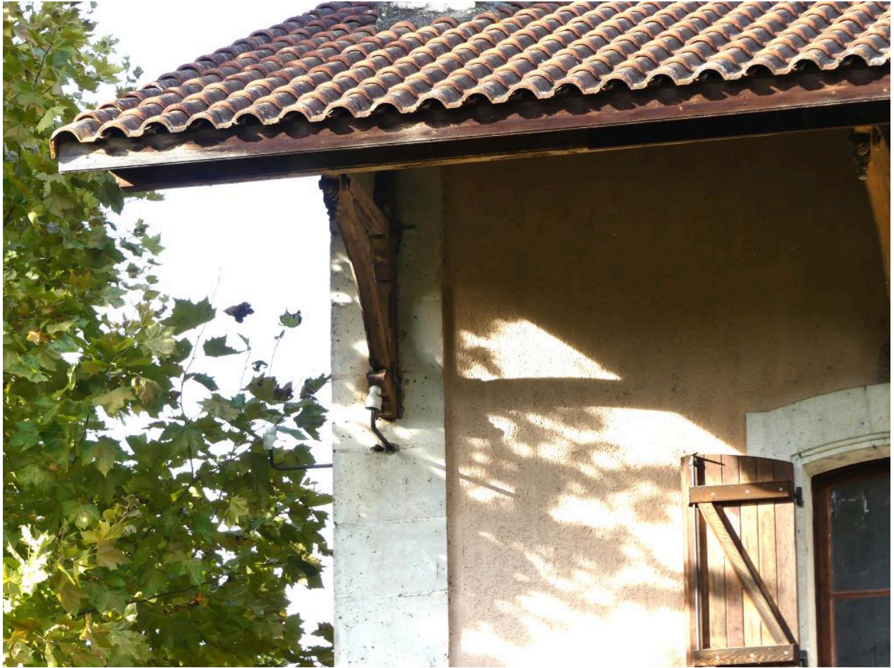
Bâtiment des voyageurs, élévation nord : détail du débord de toit..
