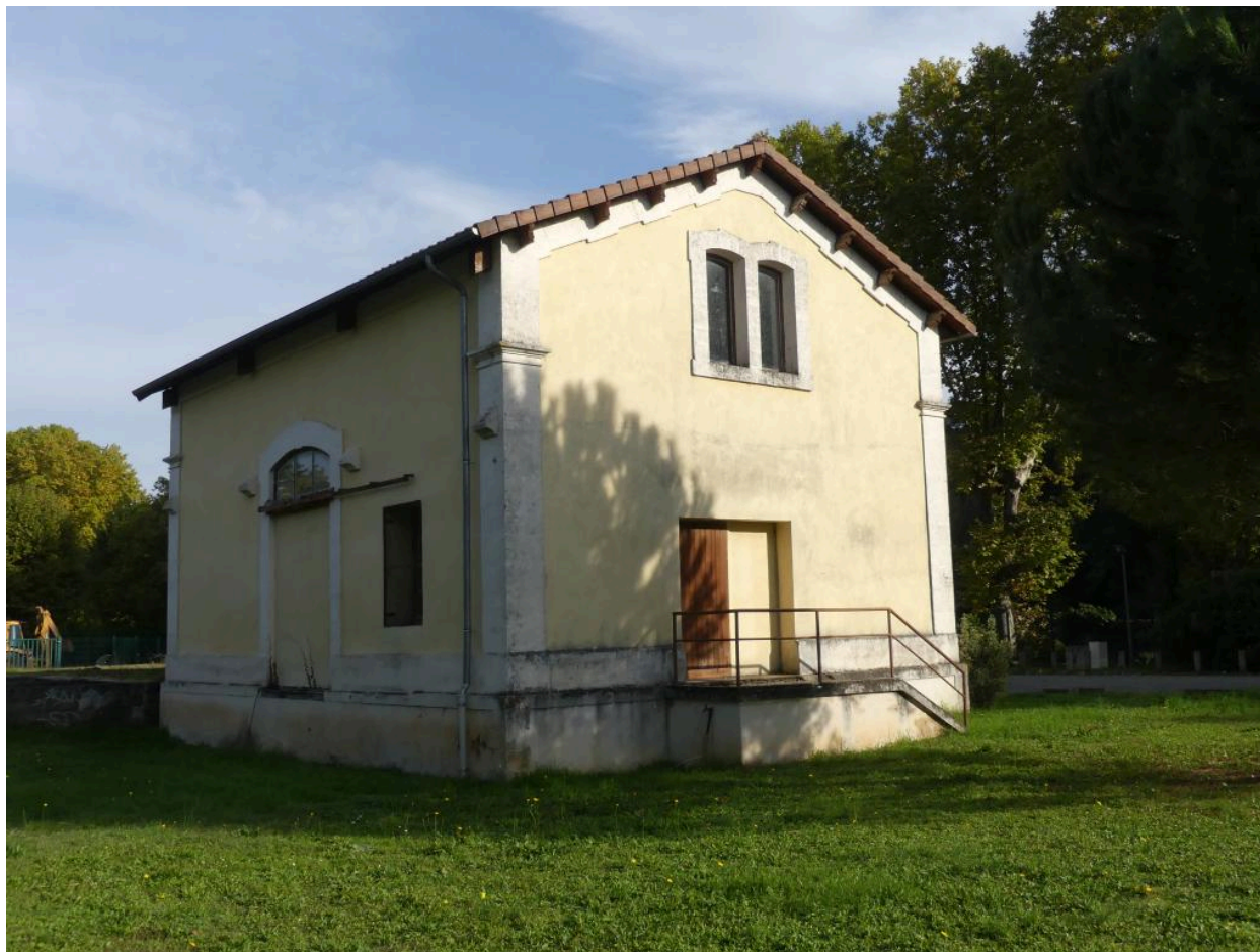
Halles à marchandises : vue depuis le nord-ouest.
