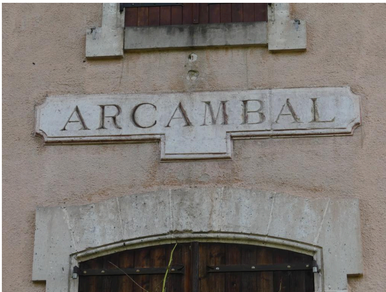
Bâtiment des voyageurs, élévation nord : cartouche indiquant le nom de la gare.
