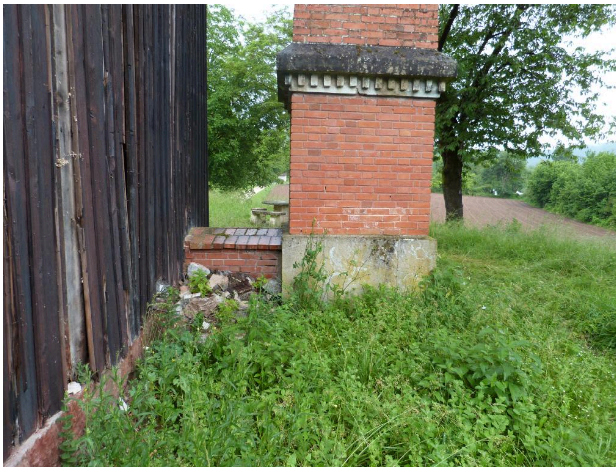
Profil du conduit de la chemin e
