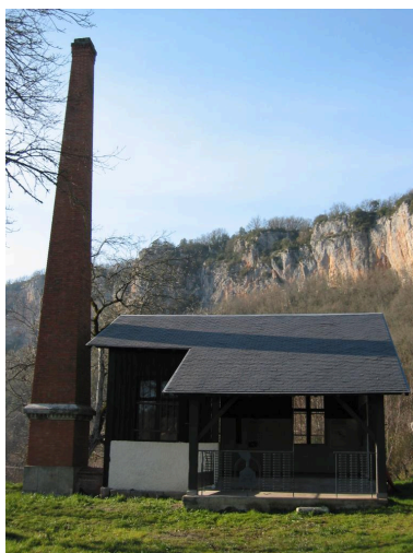
La gare : chemin e et b timent abritant la machine   vapeur fixe et la pompe Phot. Nicolas Bru IVD46_20034601045NUCA
