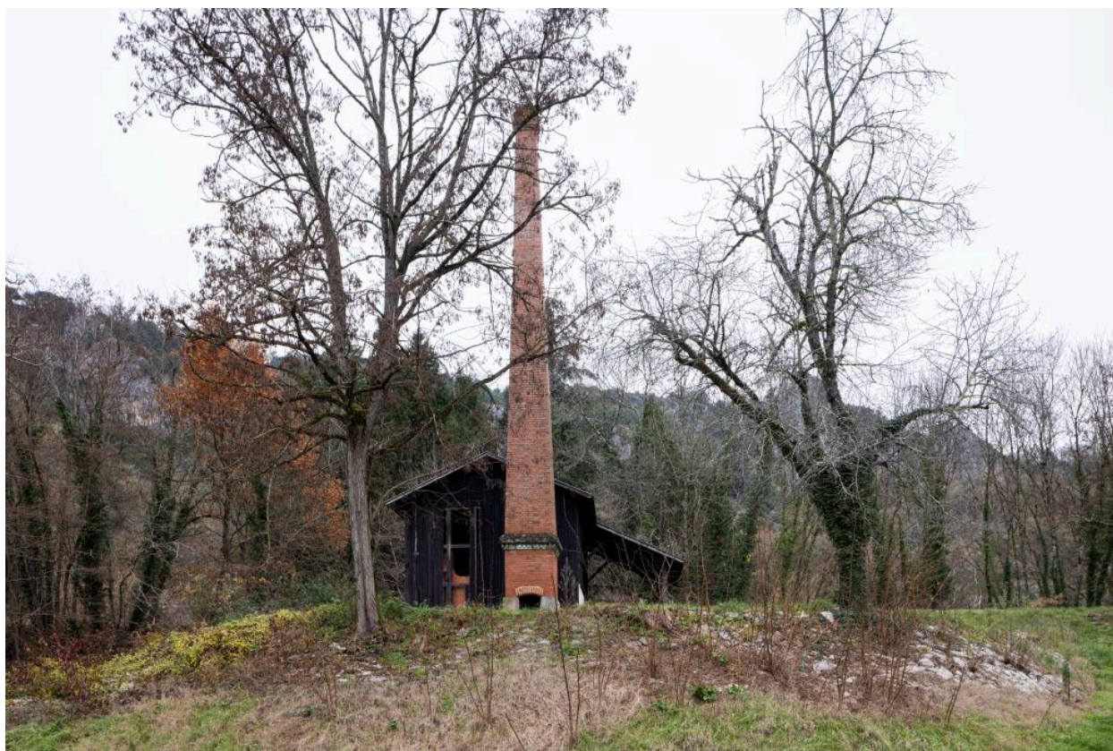
Vue depuis le sud.
