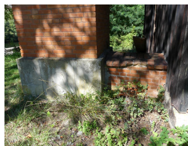
Acheminement de la chaleur du foyer vers la salle de la machine de pompage. Phot. Guillaume Bernard, Phot. Fabien Cadot IVD46_20204602103NUCA
