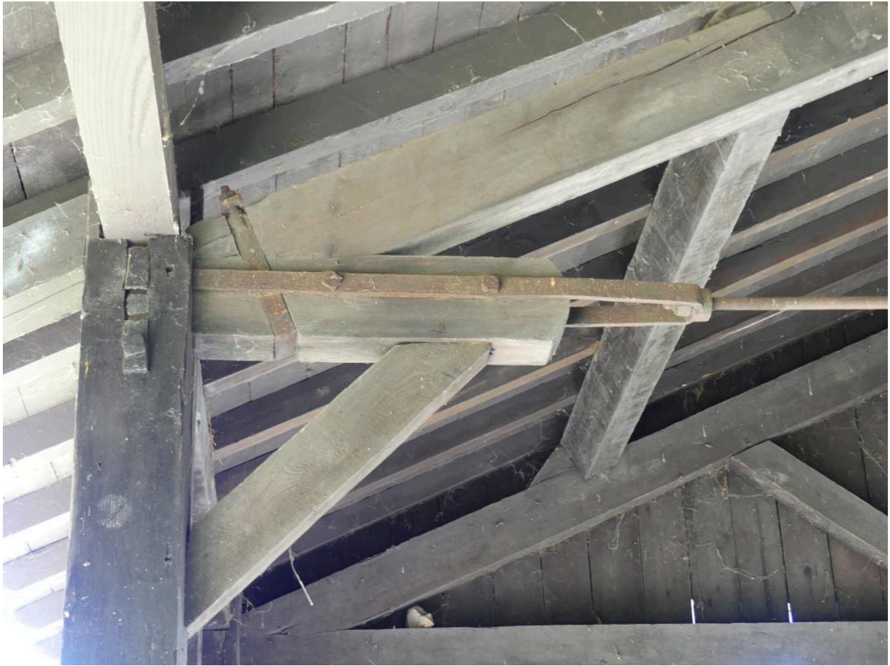
D tail de la charpente.
