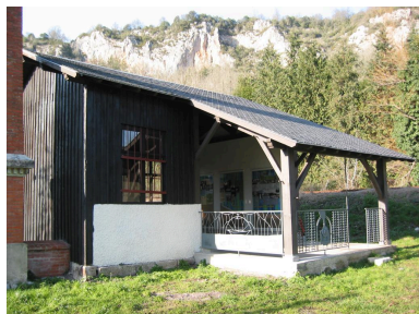
La gare : b timent abritant la machine   vapeur fixe et la pompe Phot. Nicolas Bru IVD46_20034601044NUCA
