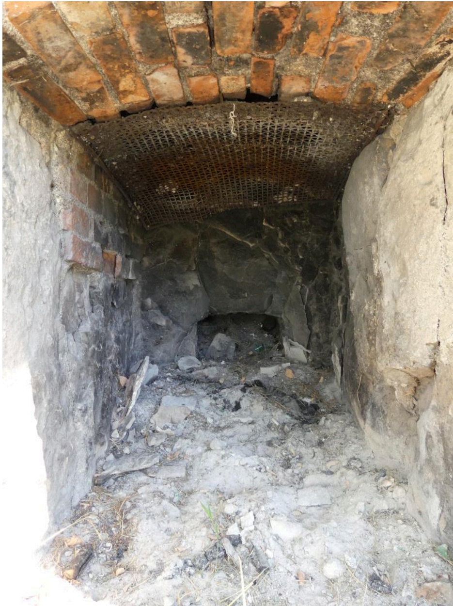
Vue int rieure du foyer.
