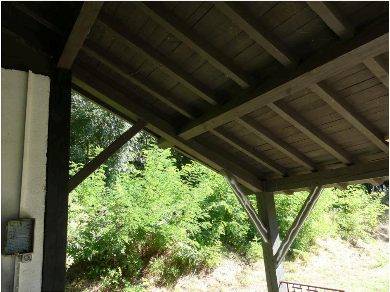
D tail de la charpente de l'appentis.
