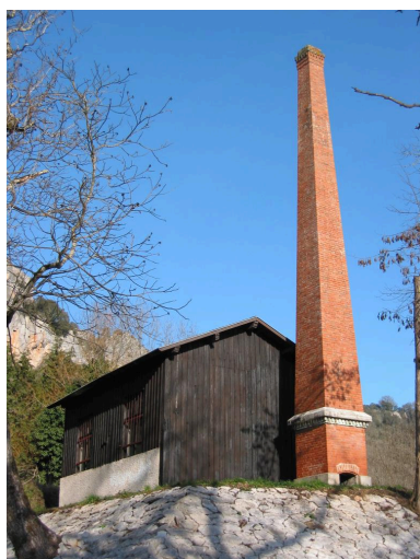
La gare : chemin e et b timent abritant la machine   vapeur fixe et la pompe Phot. Nicolas Bru IVD46_20034601040NUCA
