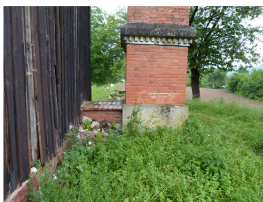
Profil du conduit de la chemin e Phot. Chlo  Doudoux IVD46_20174600539NUCA
