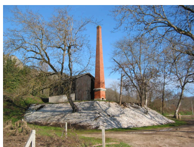
La gare : vue g n rale de la chemin e et du b timent abritant la machine   vapeur fixe et la pompe Phot. Nicolas Bru IVD46_20034601039NUCA
