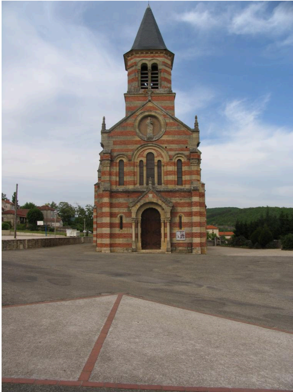
L'église paroissiale. Vue d'ensemble.
