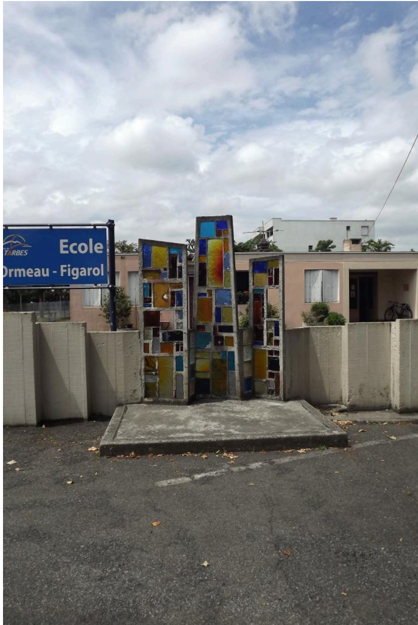
Vue d'ensemble de face depuis la rue.
