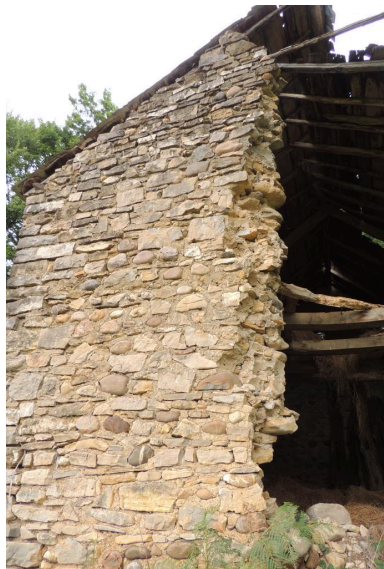
Vue de l'élévation sud. Phot. Marion Fourcayran IVD65_20146500006NUCA
