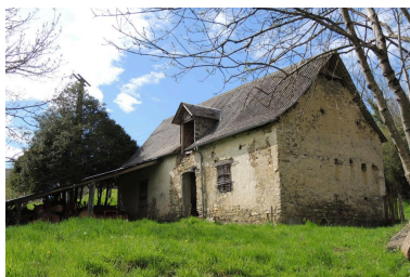
Vue de la ferme depuis le sud-est. Phot. Marion Fourcayran IVD65_20136500119NUCA
