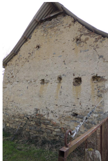
Vue de l'élévation est. Phot. Marion Fourcayran IVD65_20136500118NUCA
