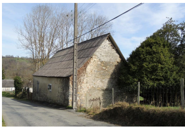
Vue des élévations nord et ouest depuis l'ouest. Phot. Marion Fourcayran IVD65_20136500116NUCA
