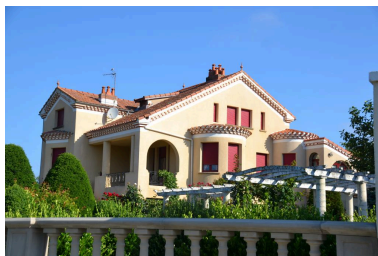
Vue générale depuis la rue (élévations sud et est). Phot. Lucas Destrem IVC09160_20200900174NUCA
