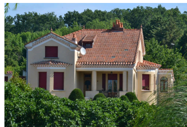
Vue générale, élévation sud. Phot. Lucas Destrem IVC09160_20200900175NUCA
