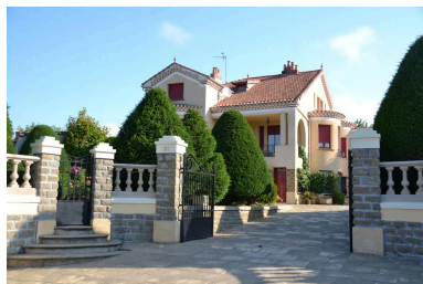
Vue générale depuis la rue (élévations sud et est). IVC09160_20200900173NUCA
