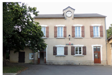
Elévation principale de l'école depuis le nord. Phot. Rémi Laffont IVD65_20146500501NUCA
