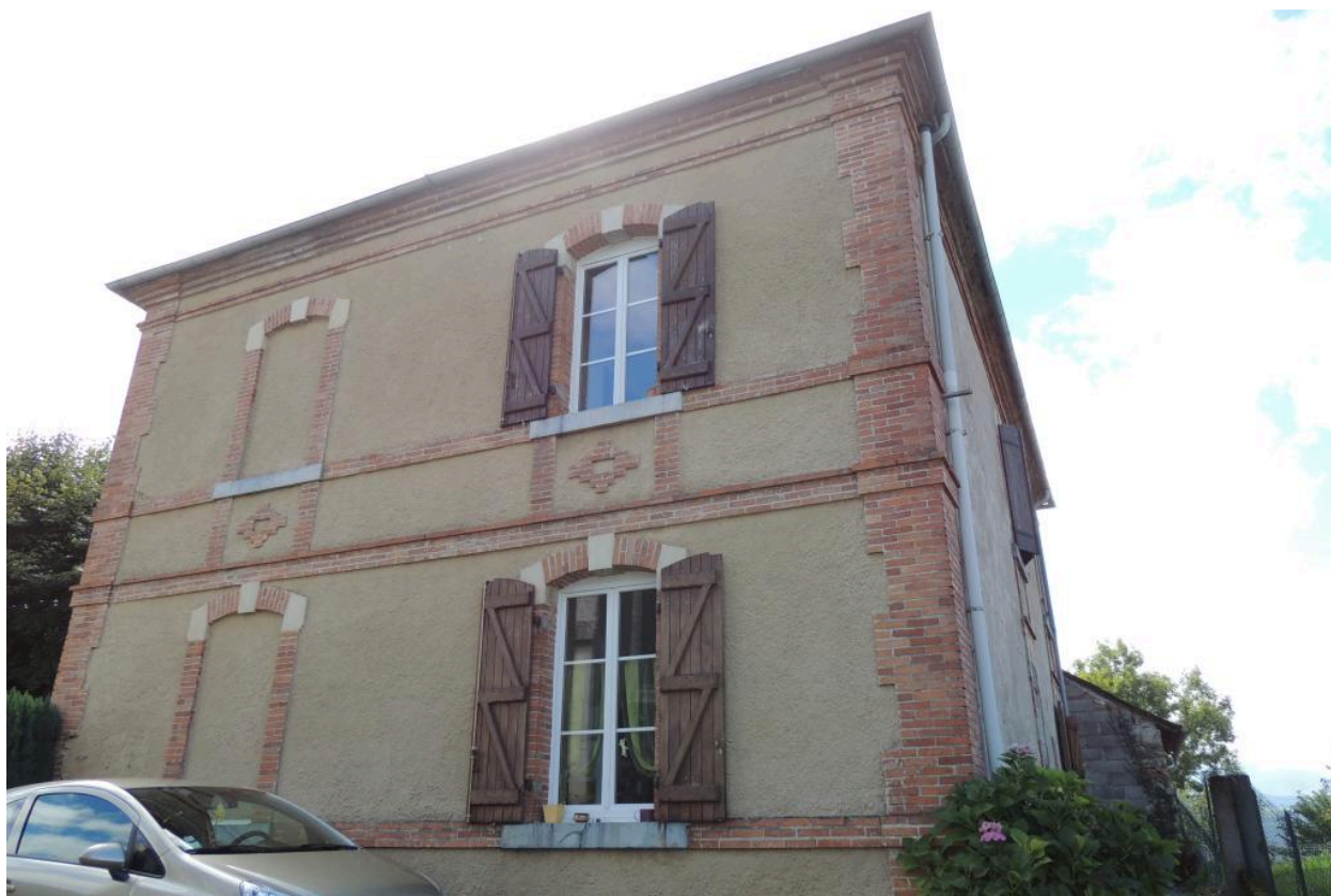
Vue de la façade latérale nord-est.
