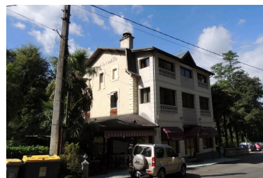
Vue de l'auberge depuis l'est. Phot. Marion Fourcayran IVD65_20146500029NUCA
