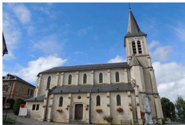
Façade latérale sud-est. Phot. Marion Fourcayran IVD65_20146500641NUCA
