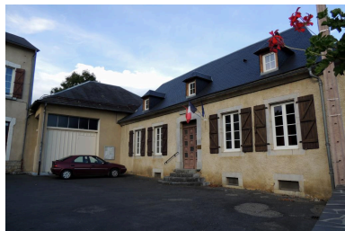
Vue de l'élévation principale de la mairie. Phot. Marion Fourcayran IVD65_20146500498NUCA
