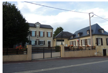
Vue de la mairie et de l'école depuis le nord. Phot. Marion Fourcayran IVD65_20146500497NUCA
