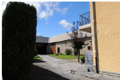
Vue générale de la cour. Phot. Marion Fourcayran IVD65_20146500635NUCA
