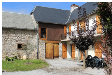
Vue de l'angle nord-ouest de la cour. Phot. Marion Fourcayran IVD65_20146500637NUCA
