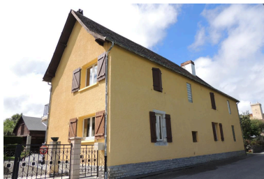
Vue de la façade nord-est. Phot. Marion Fourcayran IVD65_20146500638NUCA
