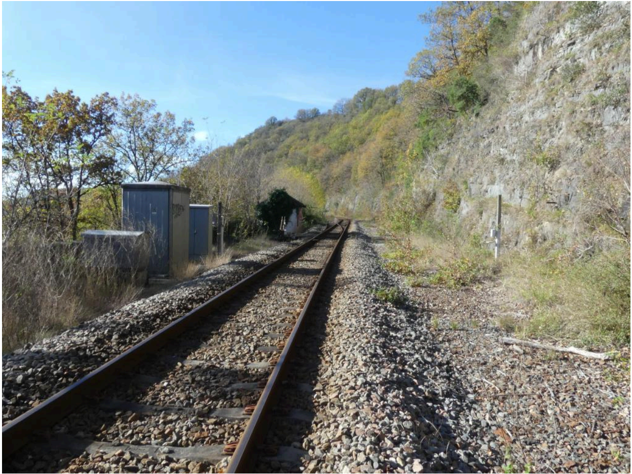
Vue de la voie, fin de la ligne à Capdenac.
