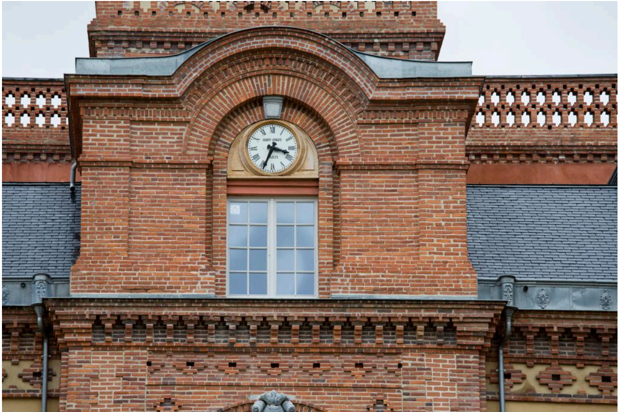
La tour : détail de la baie centrale.
