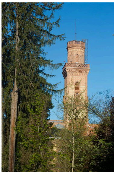
La tour Massey : vue partielle. Phot. Philippe Poitou IVR73_20156551026NUCA
