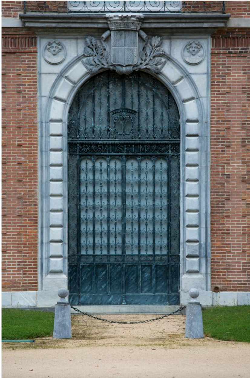
L'ancienne porte d'entrée du musée au sud, sur jardin.
