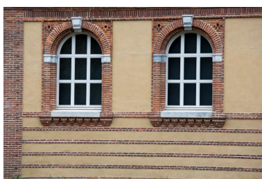
Façade sud sur jardin : baies hautes du rez-de-chaussée (détail). Phot. Philippe Poitou IVR73_20156550060NUCA
