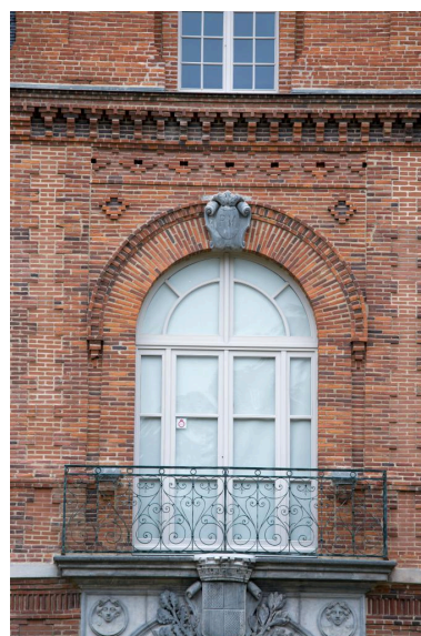
Premier étage côté sud : la grande baie centrale avec balcon. Phot. Philippe Poitou IVR73_20156550057NUCA
