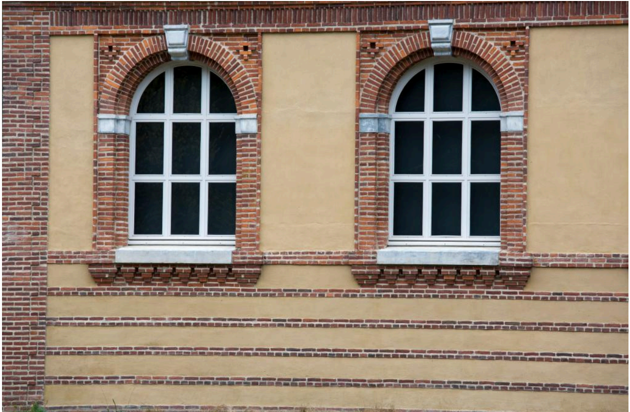
Façade sud sur jardin : baies hautes du rez-de-chaussée (détail).
