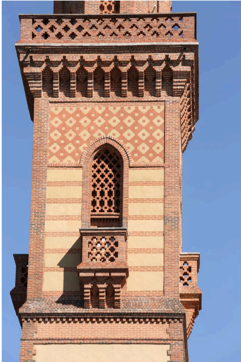
La tour Massey (détail des baies).
