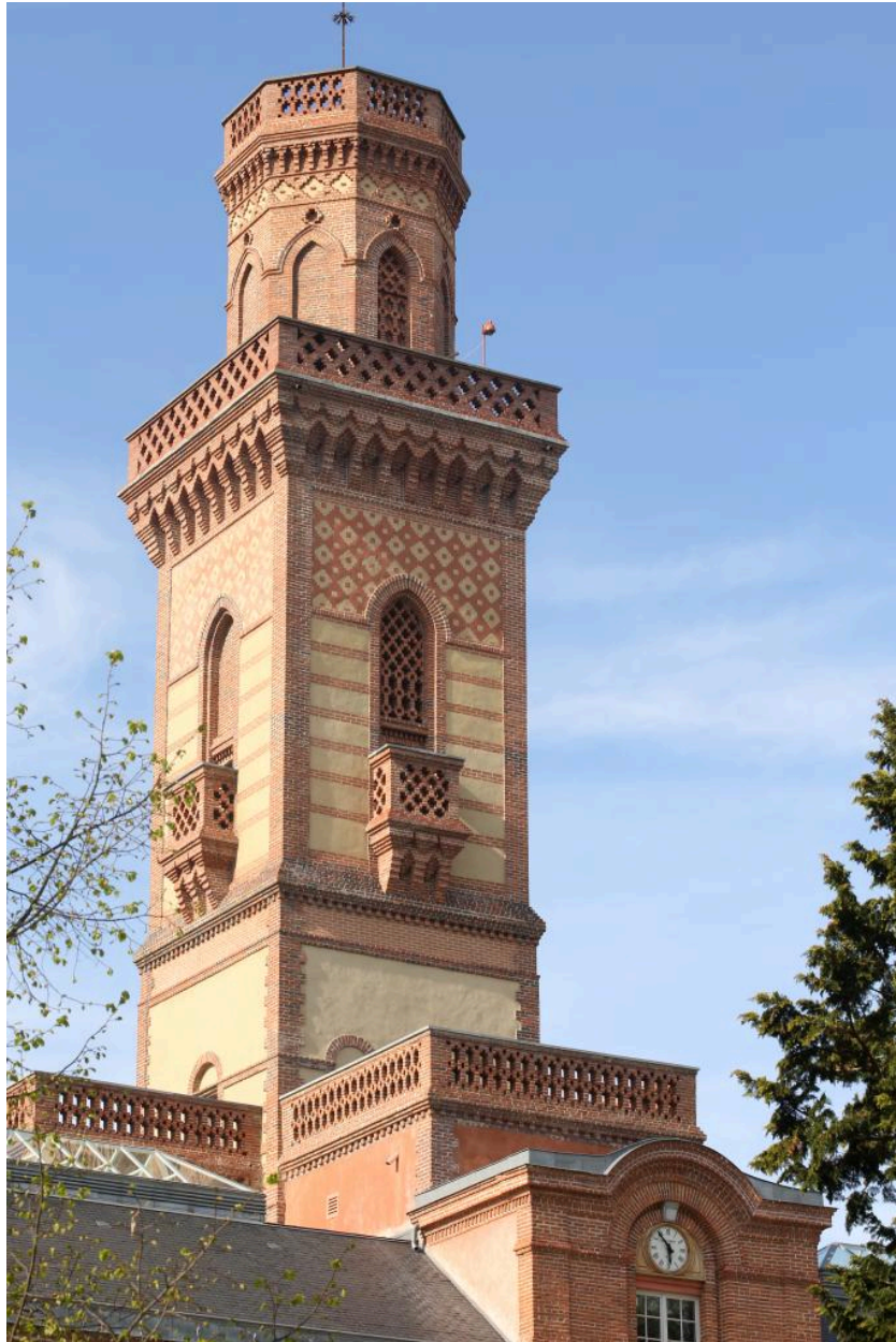
La tour Massey : vue d'ensemble.
