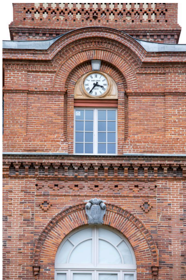
La tour, soubassement : baie de l'horloge. Phot. Philippe Poitou IVR73_20156550058NUCA
