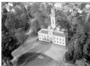
Photographie aérienne. Phot. Roger Henrard IVR73_19866500058N
