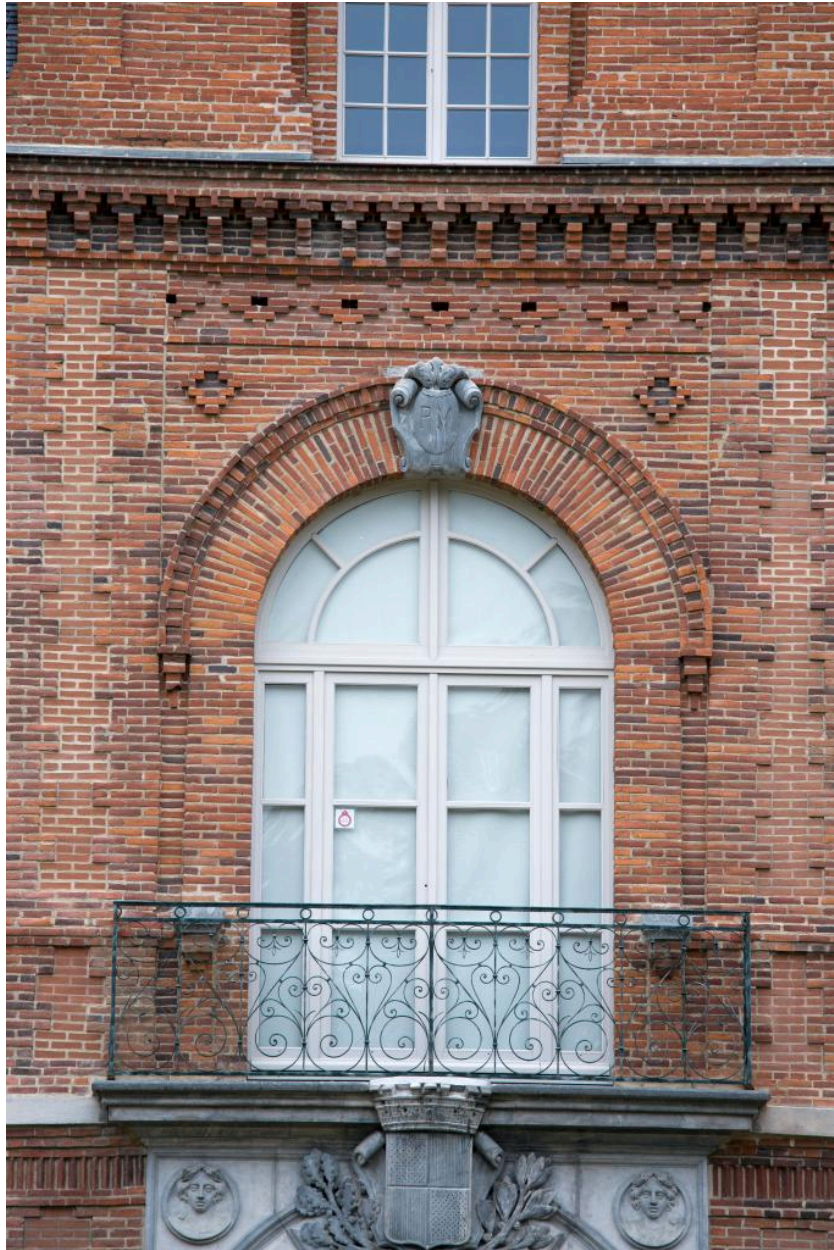
Premier étage côté sud : la grande baie centrale avec balcon.
