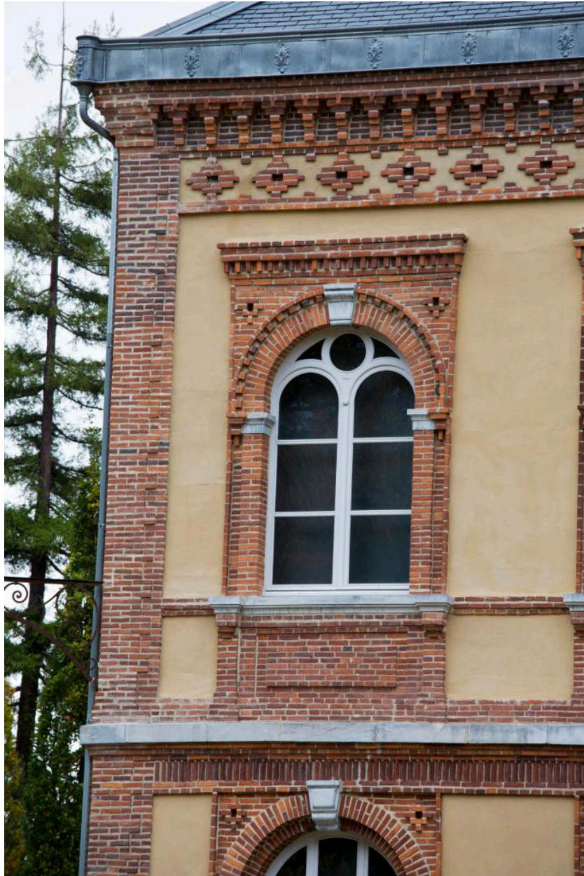
Façade sud sur jardin : baie du premier étage (détail).
