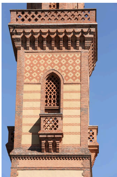
La tour Massey (détail des baies). Phot. Philippe Poitou IVR73_20156551028NUCA
