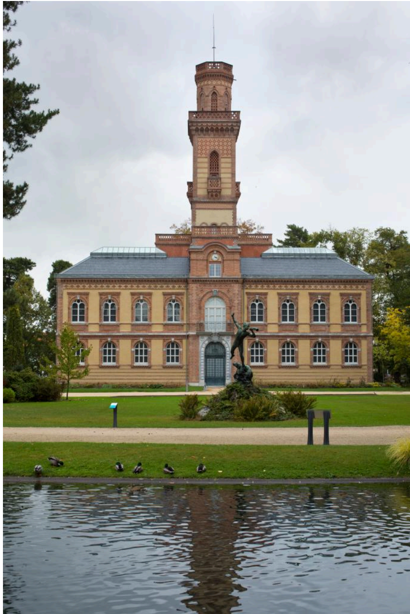
Vue d'ensemble de la demeure depuis la pièce d'eau.
