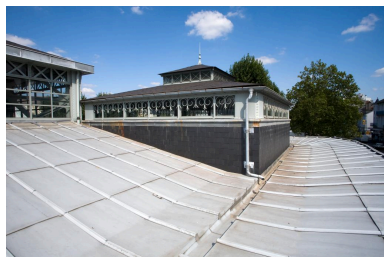
Détail de la toiture de la halle et de la marquise et détail du pavillon d'angle. Phot. Philippe Benoist IVR73_20086501023NUCA
