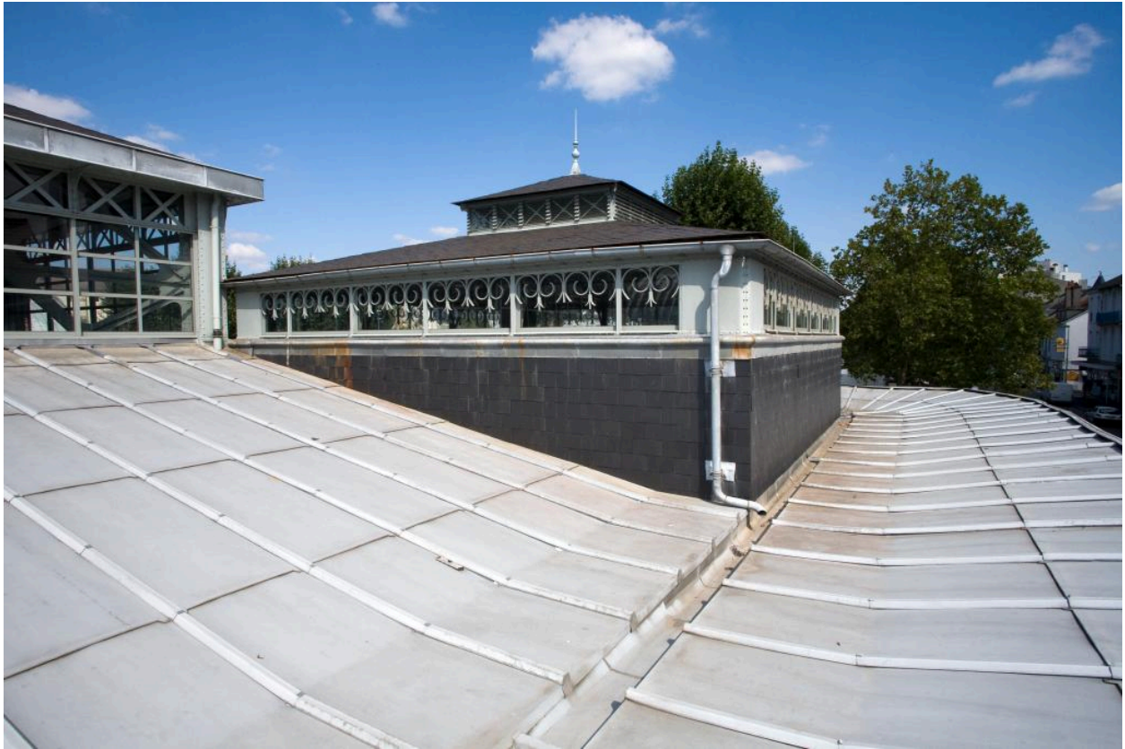
Détail de la toiture de la halle et de la marquise et détail du pavillon d'angle.
