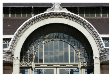
Détail du double décor à godron présent sur la corniche en plein-cintre surmontant le passage situé au centre de la façade nord-ouest. Phot. Philippe Benoist IVR73_20086501020NUCA
