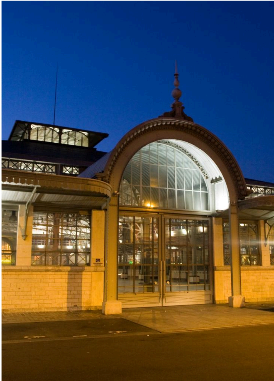
Détail de l'entrée située sur la façade nord-ouest.
