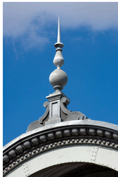
Détail de l'épi de faitage surmontant la corniche en plein-cintre du passage situé dans la façade nord-ouest. Phot. Philippe Benoist IVR73_20086501021NUCA
