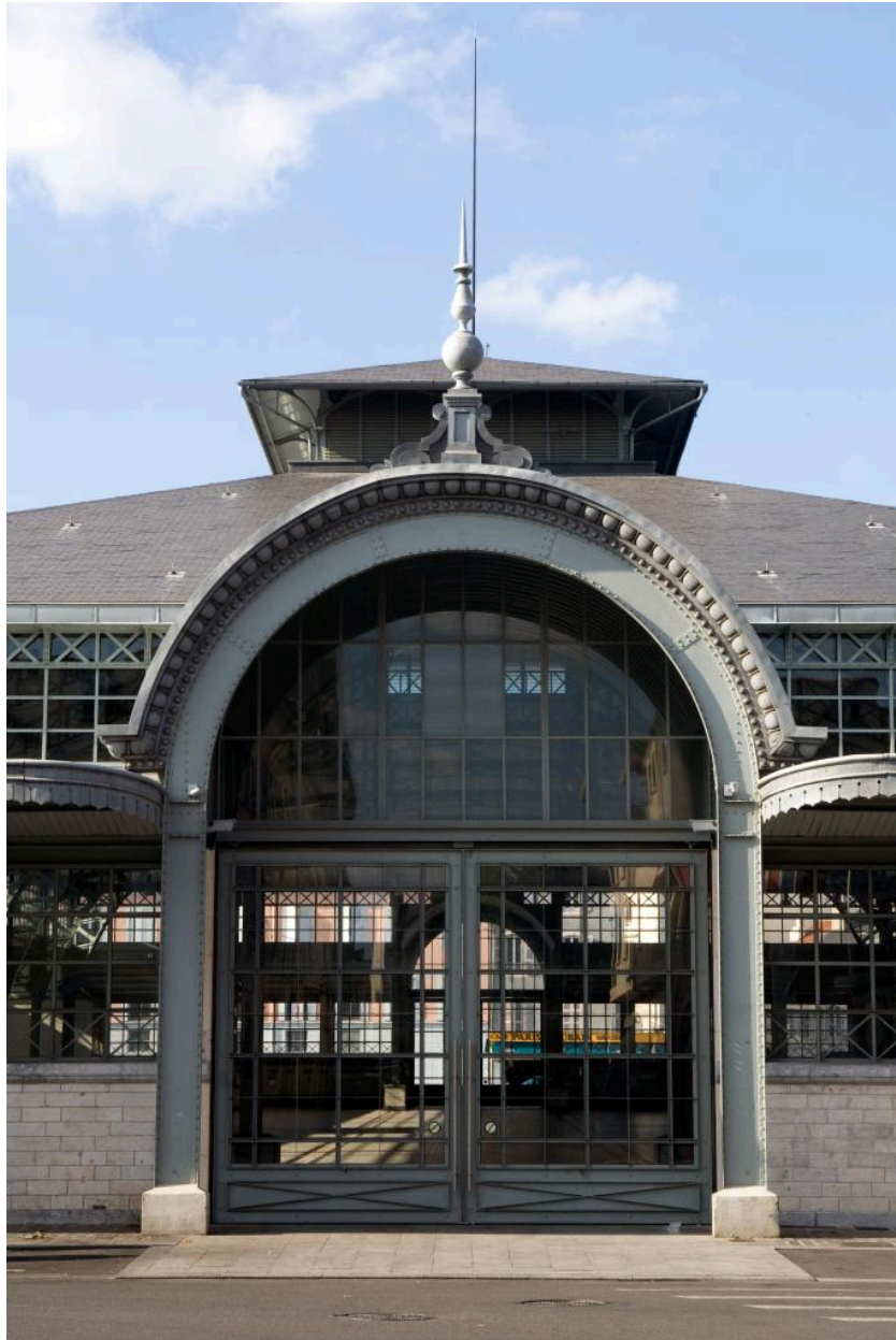
Détail du passage situé sur la façade nord-ouest.
