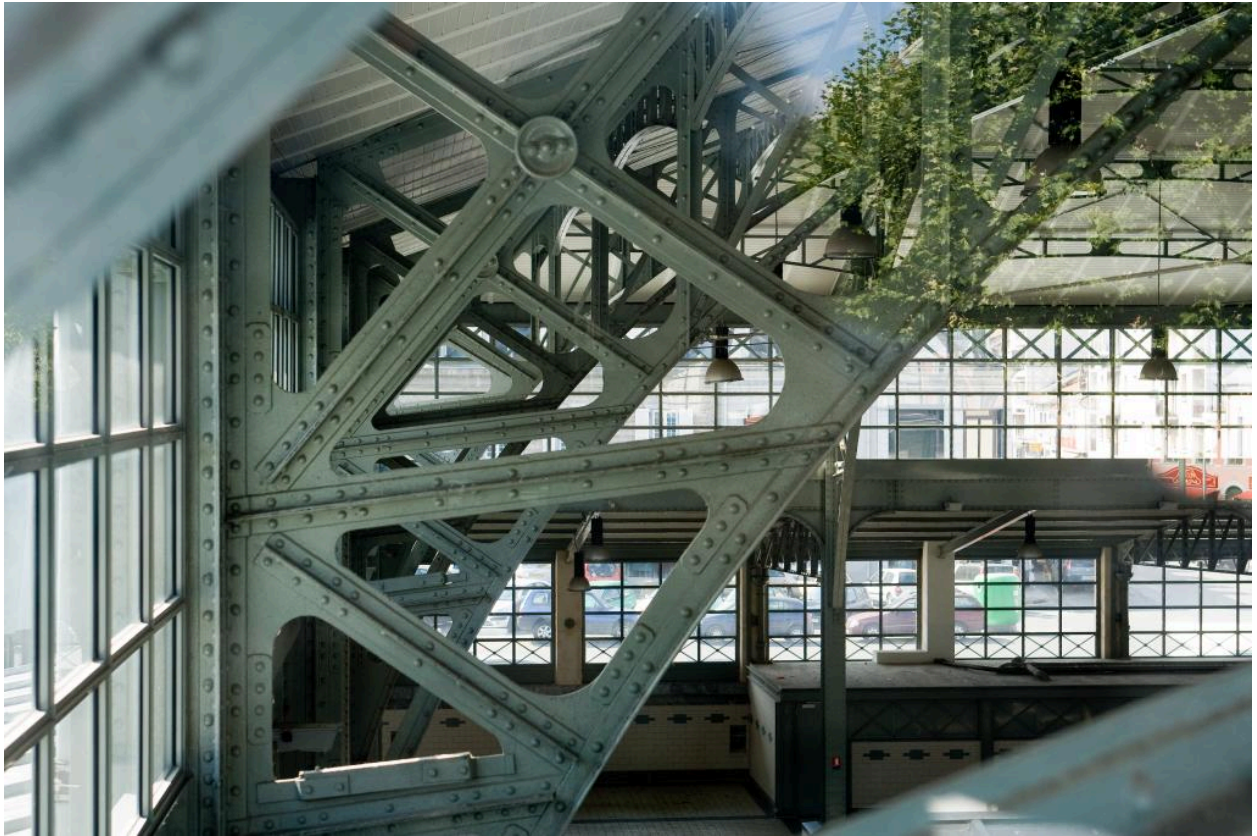
Détail d'assemblage de la charpente métallique.
