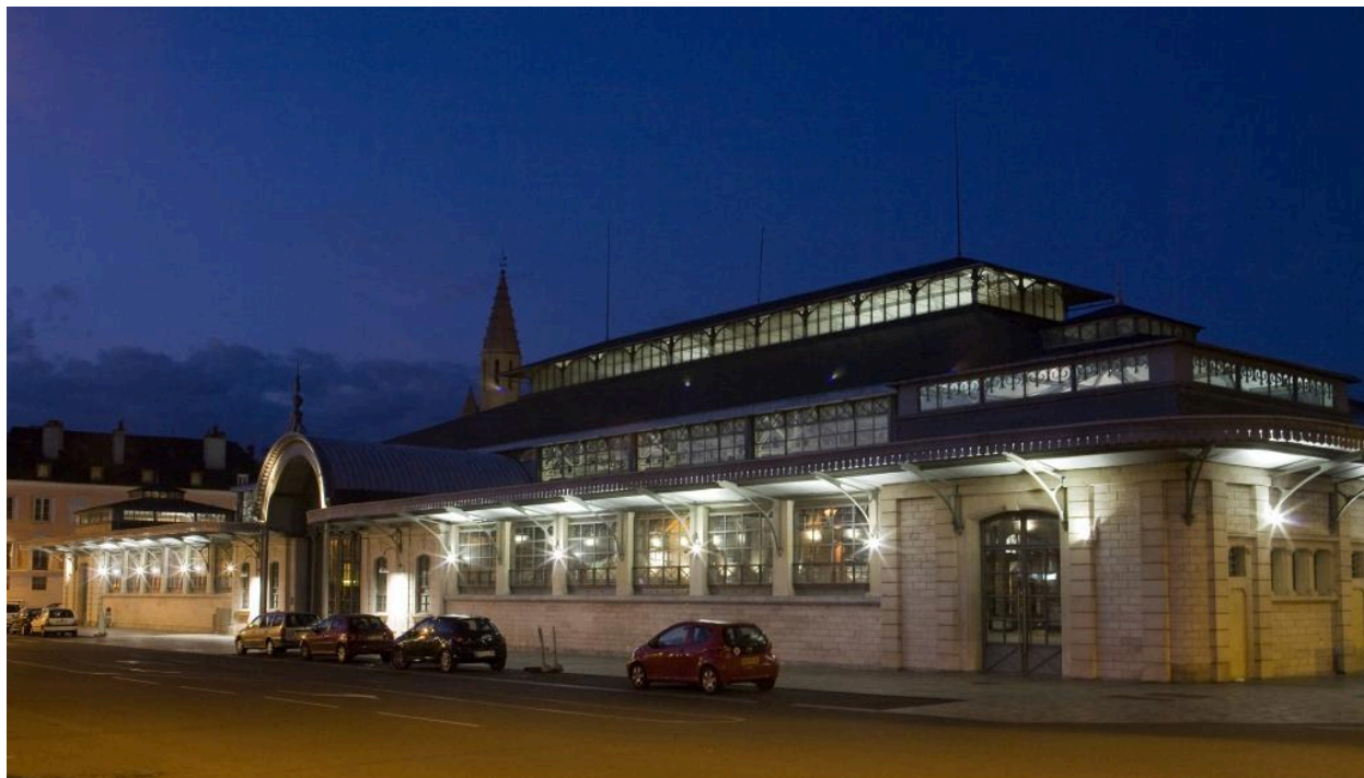
Vue nocturne de la façade sud-ouest.
