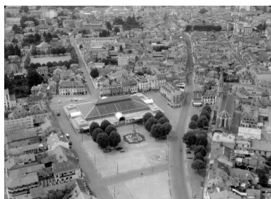
Photographie aérienne (marché, église). Phot. Roger Henrard IVR73_19866500067N
