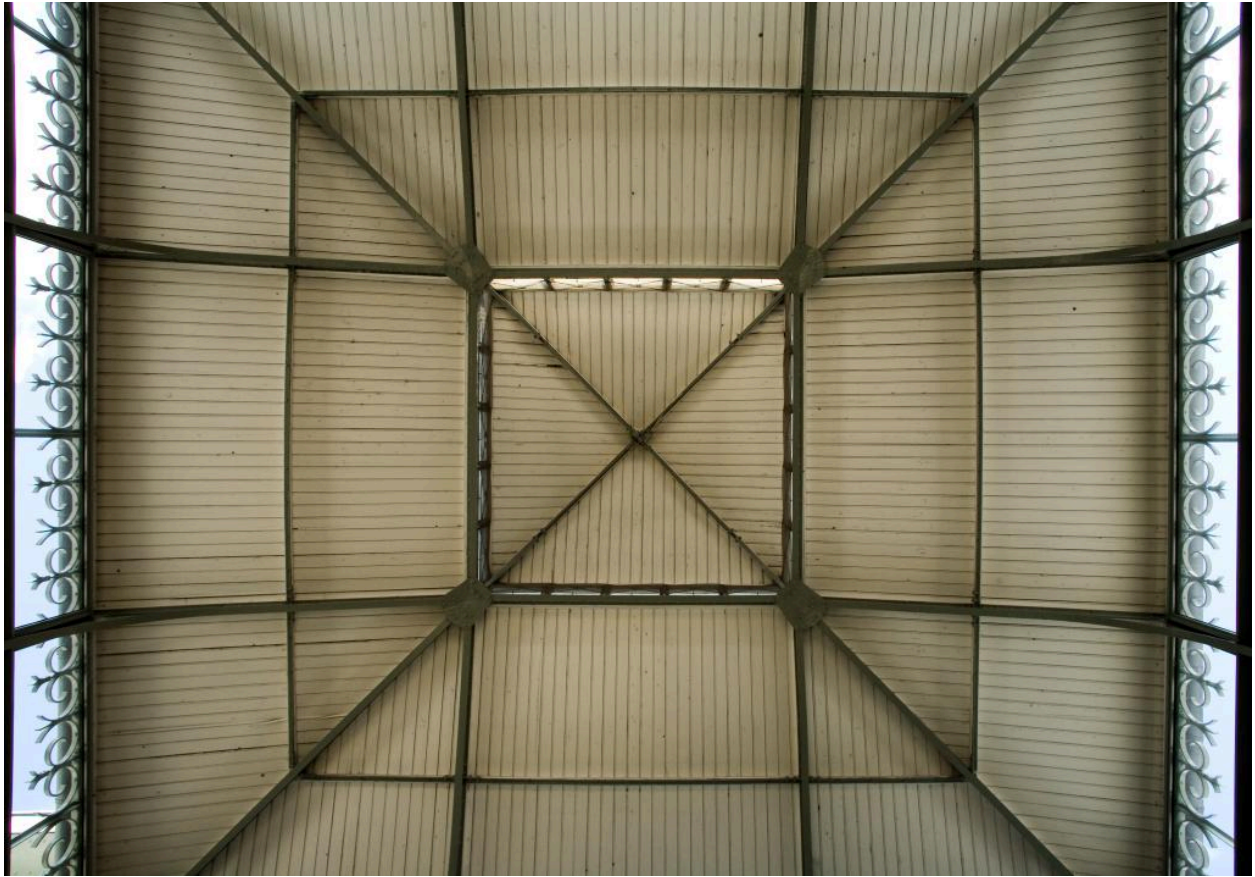
Vue de détail de la charpente du lanterneau d'un des pavillons d'angle.
