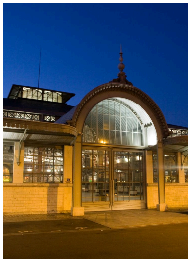
Détail de l'entrée située sur la façade nord-ouest. Phot. Philippe Benoist IVR73_20086501029NUCA
