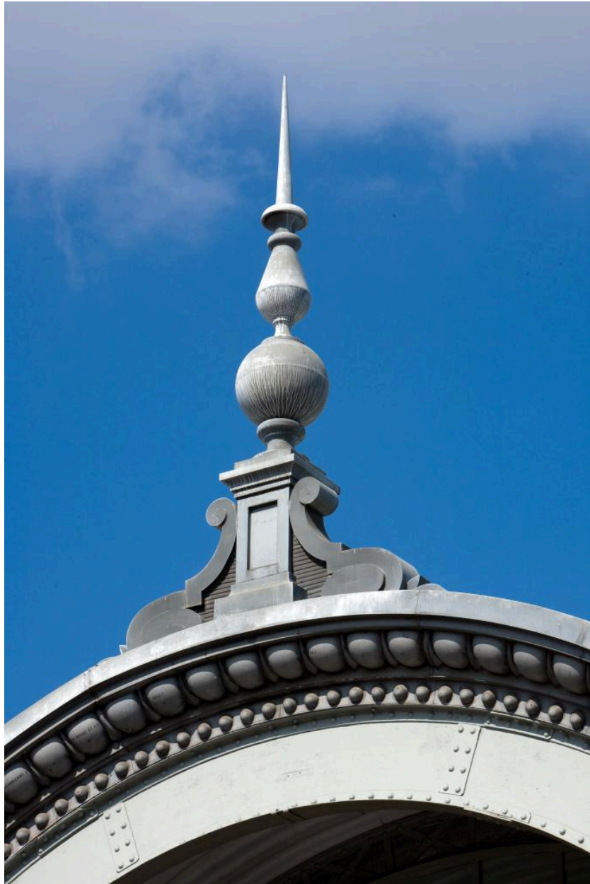
Détail de l'épi de faitage surmontant la corniche en plein-cintre du passage situé dans la façade nord-ouest.
