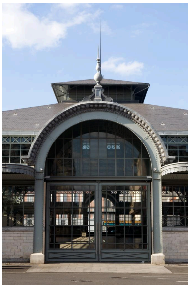
Détail du passage situé sur la façade nord-ouest. Phot. Philippe Benoist IVR73_20086501019NUCA
